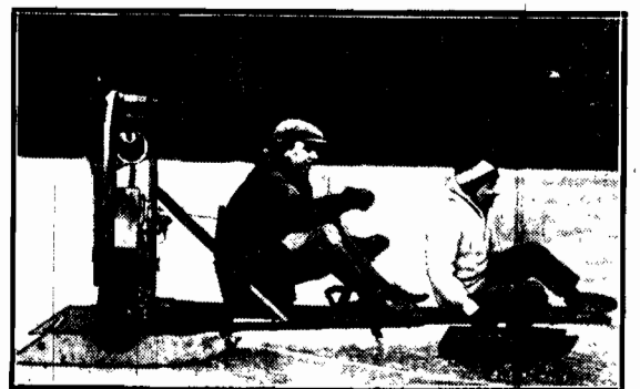
Mały motorok spalnowy, umieszczony z tyłu na sanach, wprowadza w ruch śmigło, to zaś nadaje dość szybki bieg saniom, zwłaszcza po lodzie
