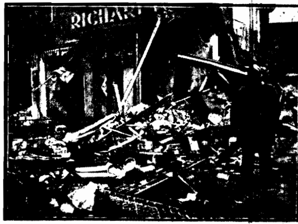
Ruiny sklepów parterowych domu przy „Landsberger Allee” w Berlinie, po wybuchu zbiornika gazowego.
