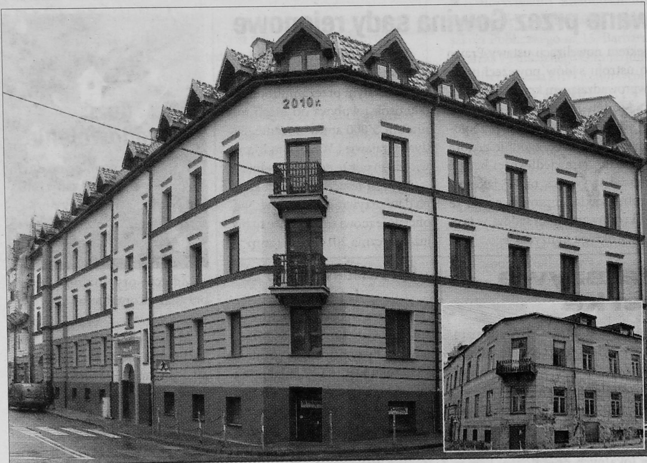
Kamienica Wiejska 10 sprzed kilkunastu lat oraz po odbudowie
