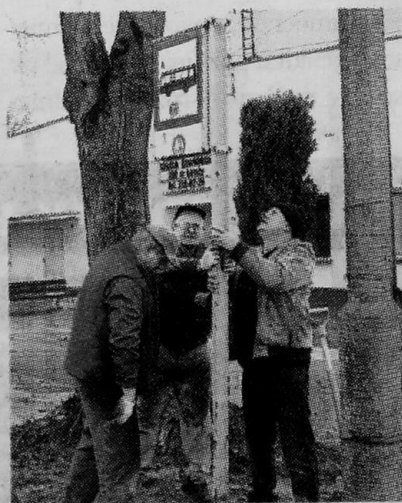
Pracownicy ZDZ ustawiają przystanek MPK na nowej, tymczasowej pętli przed wejściem do szkoły
