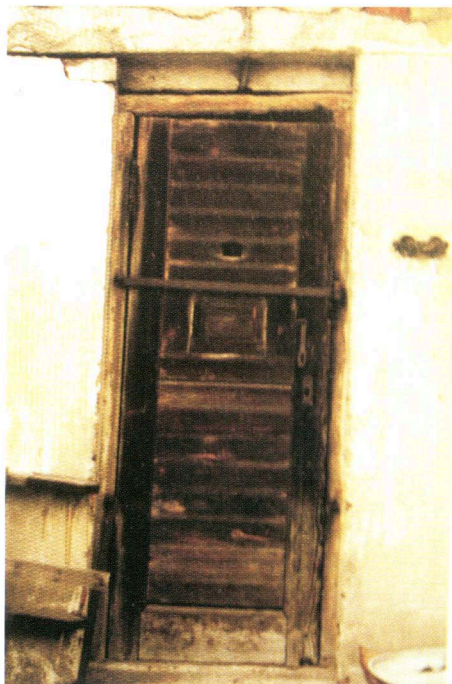
Także zachowane drzwi do karceru w piwnicy budynku
