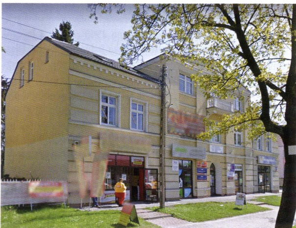
Kamienica przy Al. Legionów – obecnie
