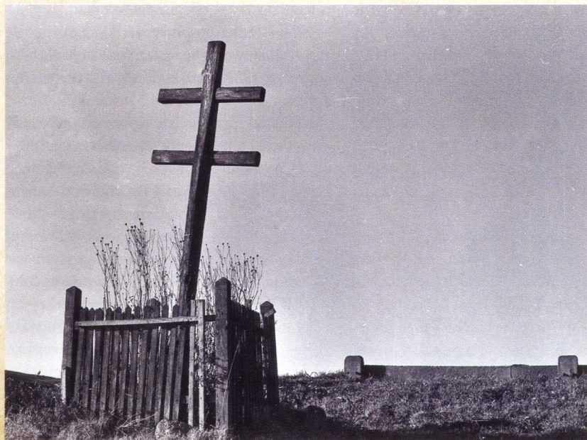
Karawaka w Łomży przed mostem piętnickim. Stan sprzed 1983 roku.
