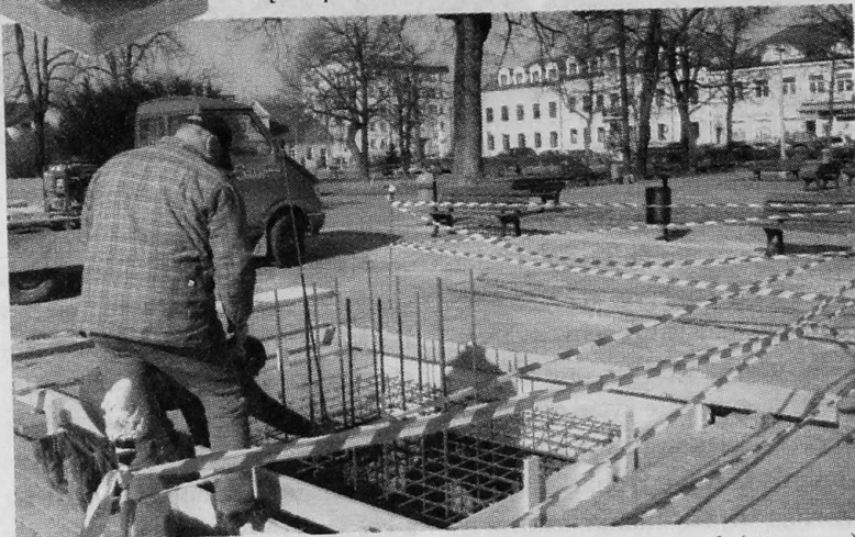
Projekt pomnika autorstwa Roberta Sobocińskiego; we wtorek (11 marca) zaczęła się budowa cokołu, która pochłonie 8,5 m sześć. betonu
