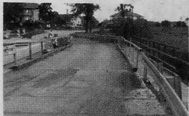
Budowa mostu we Wnorach Wypychach
