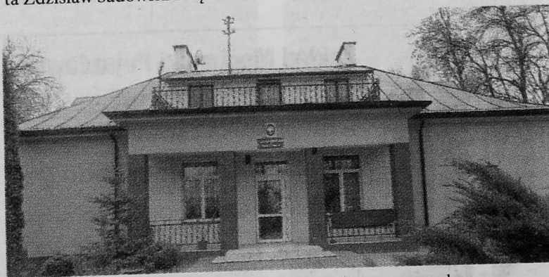
Szkoła w Pęchratce, w budowie której pomagał Bolesław Podedworny
