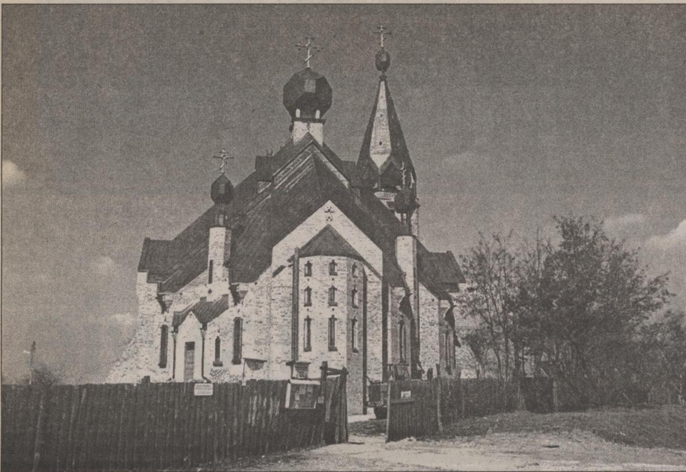
Przy ul. Sikorskiego gotowy jest już stan surowy cerkwi pw. Zmartwychwstania Pańskiego
