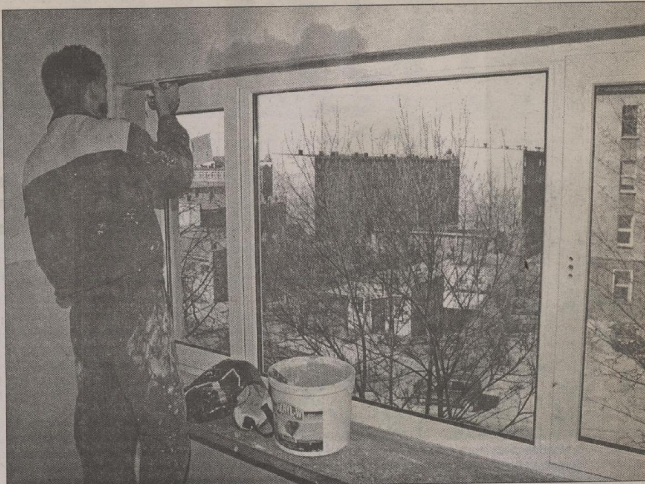
Wiosną nowe okna pojawiły się na klatkach schodowych przy ul. Antoniukowskiej 5a
