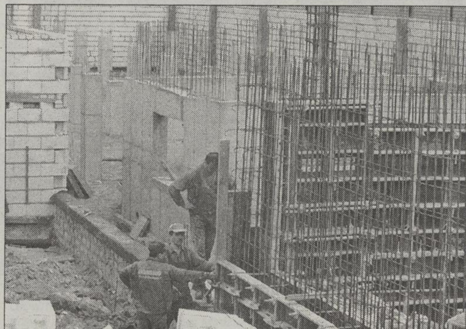
Budowa krytej pływalni już ruszyła. Na razie powstają fundamenty przyszłego kompleksu wypoczynkowego.
