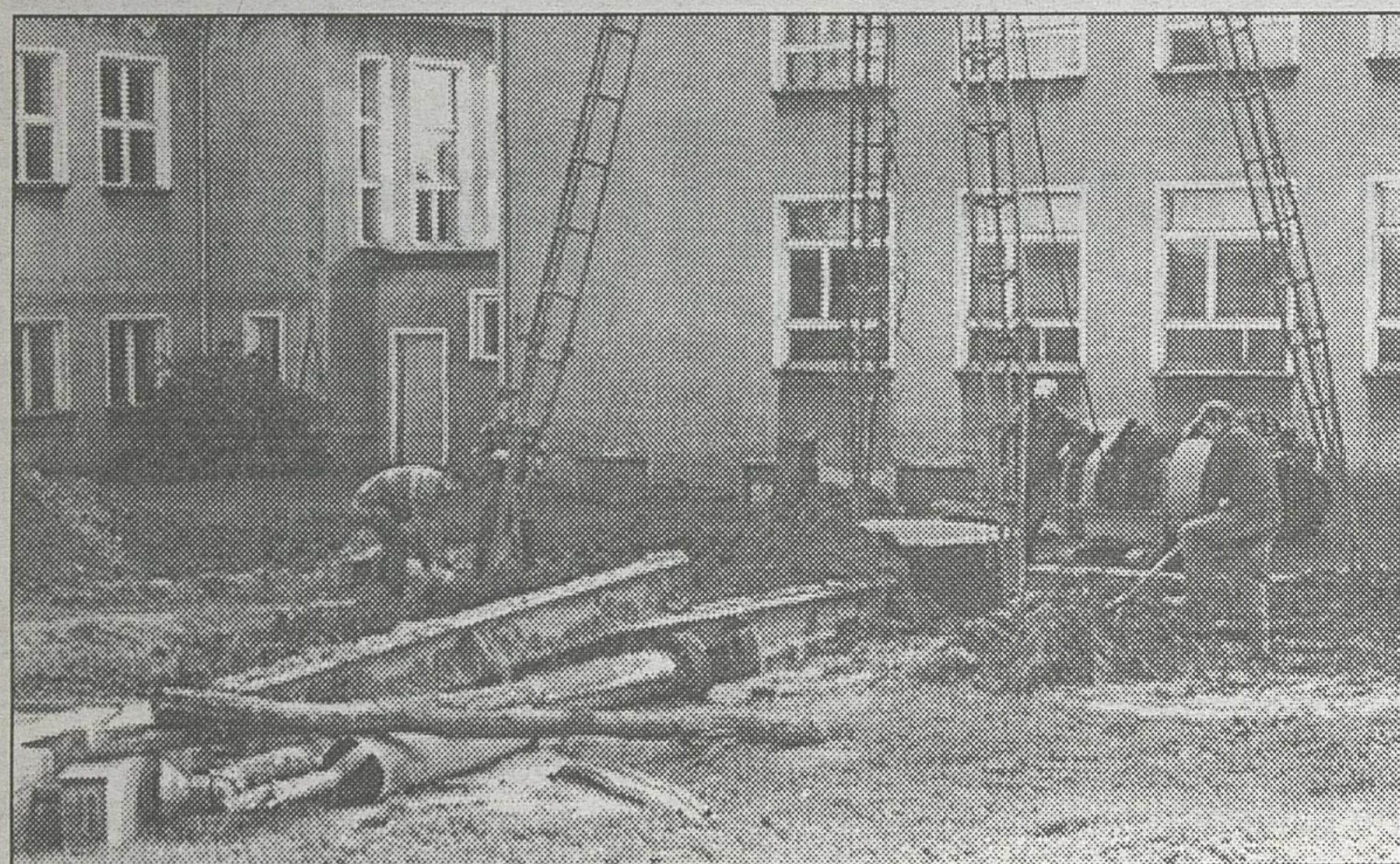
W Szkole Podstawowej w Uhowie trwają prace prowadzące do zainstalowania pomp ciepła usprawniających ogrzewanie budynku
