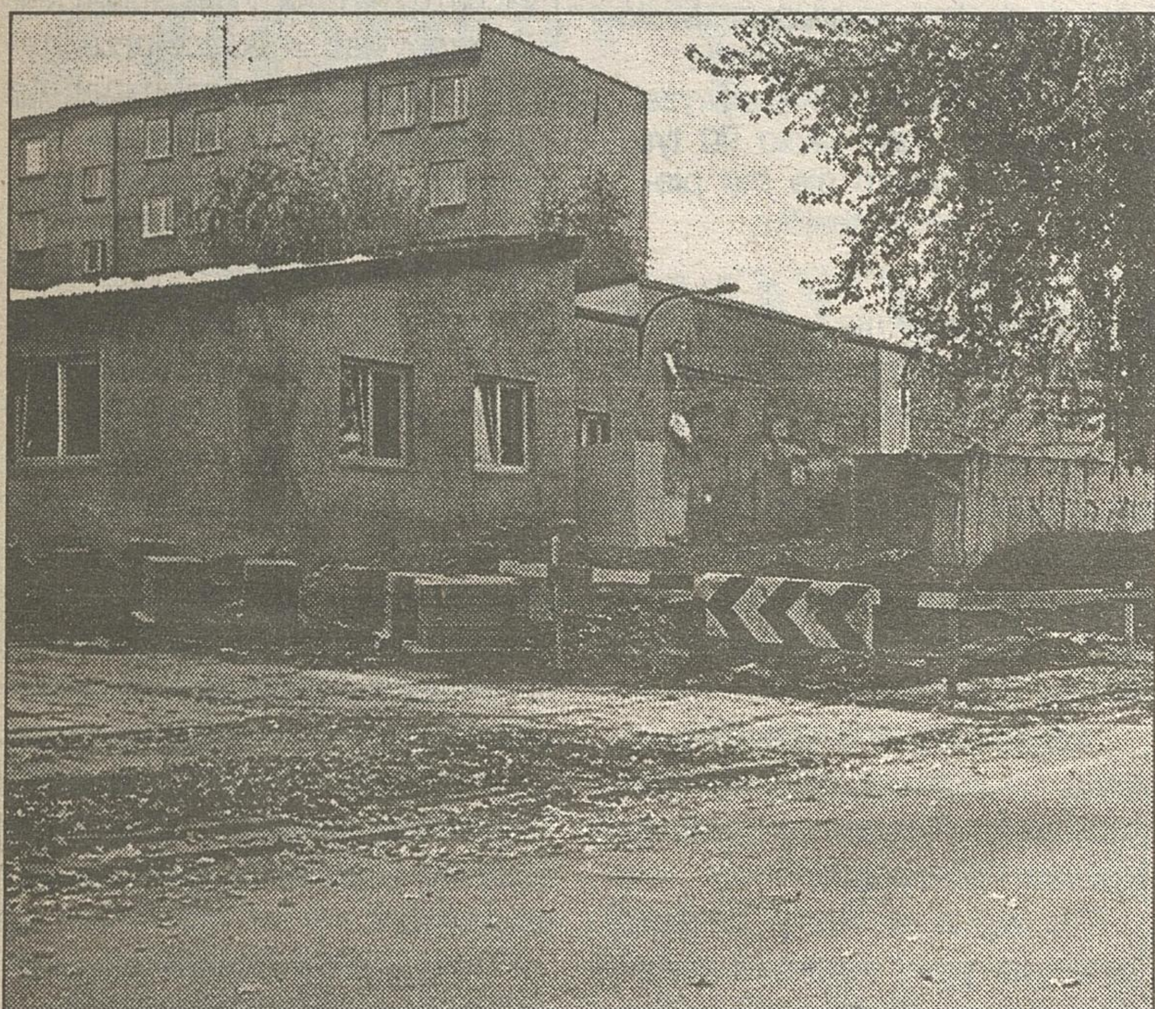
Największą kotłownią po modernizacji będzie obiekt przy ul. Polnej, dlatego potrzebna była rozbudowa budynku
