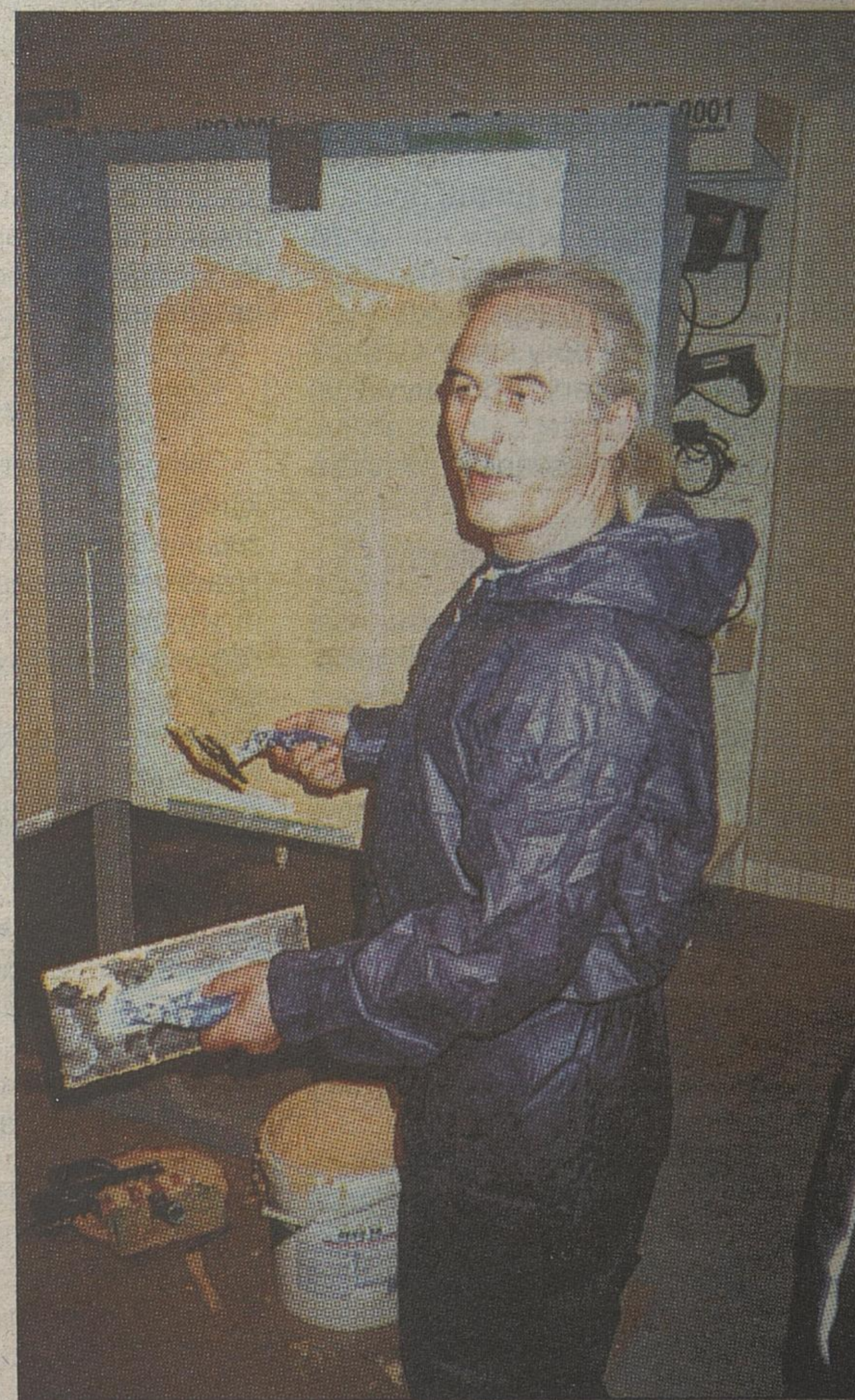
Układanie tynku strukturalnego nie jest trudne i architekci dawali sobie z tym doskonale radę
