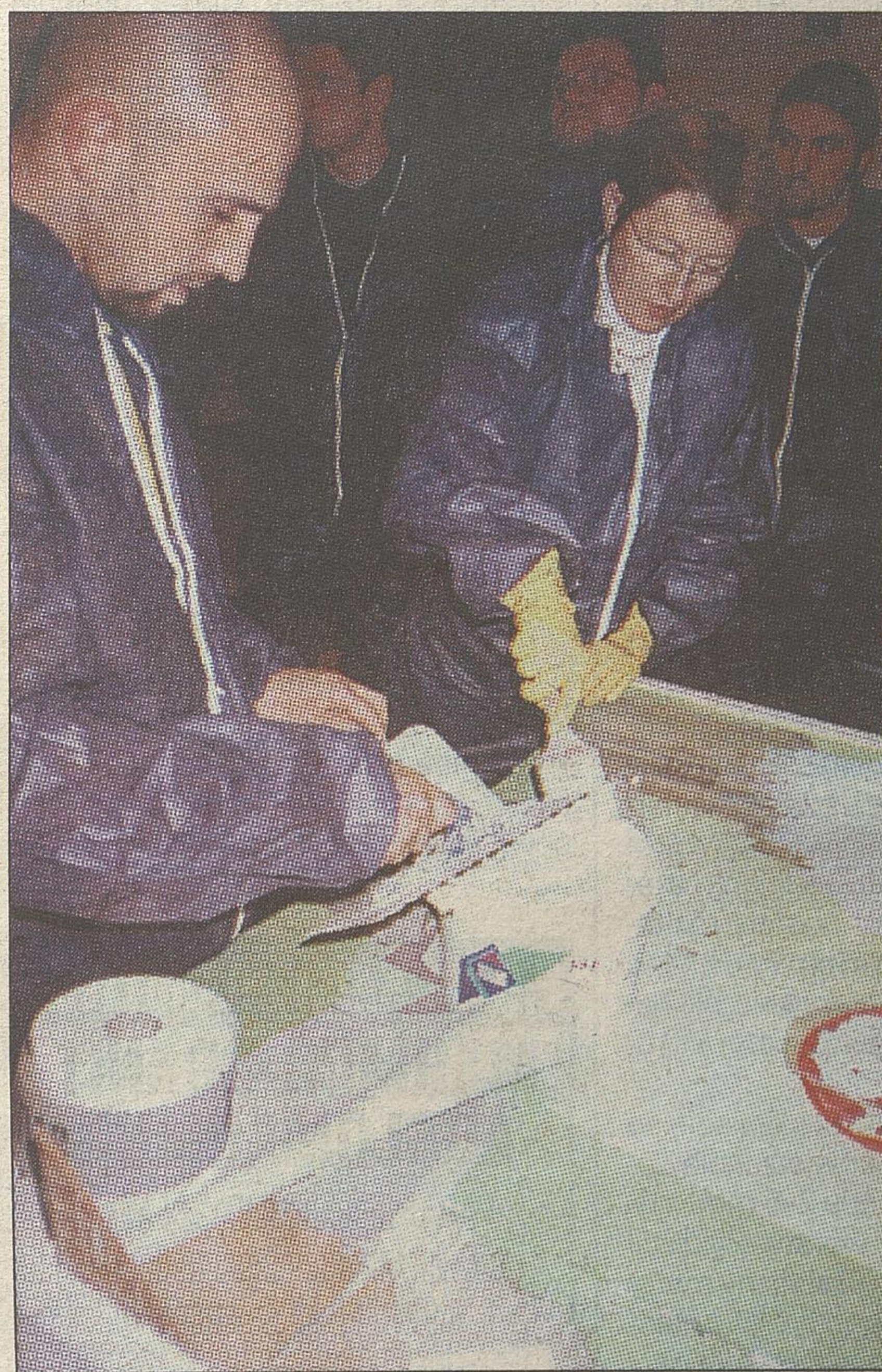
Jak uszczelnić połączenie ściany i podłogi przed ułożeniem terakoty oraz glazury sprawdzały panie pod okiem Grzegorza Sierki (z lewej), specjalisty z Podlaskiego Centrum Doradztwa Budowlanego
