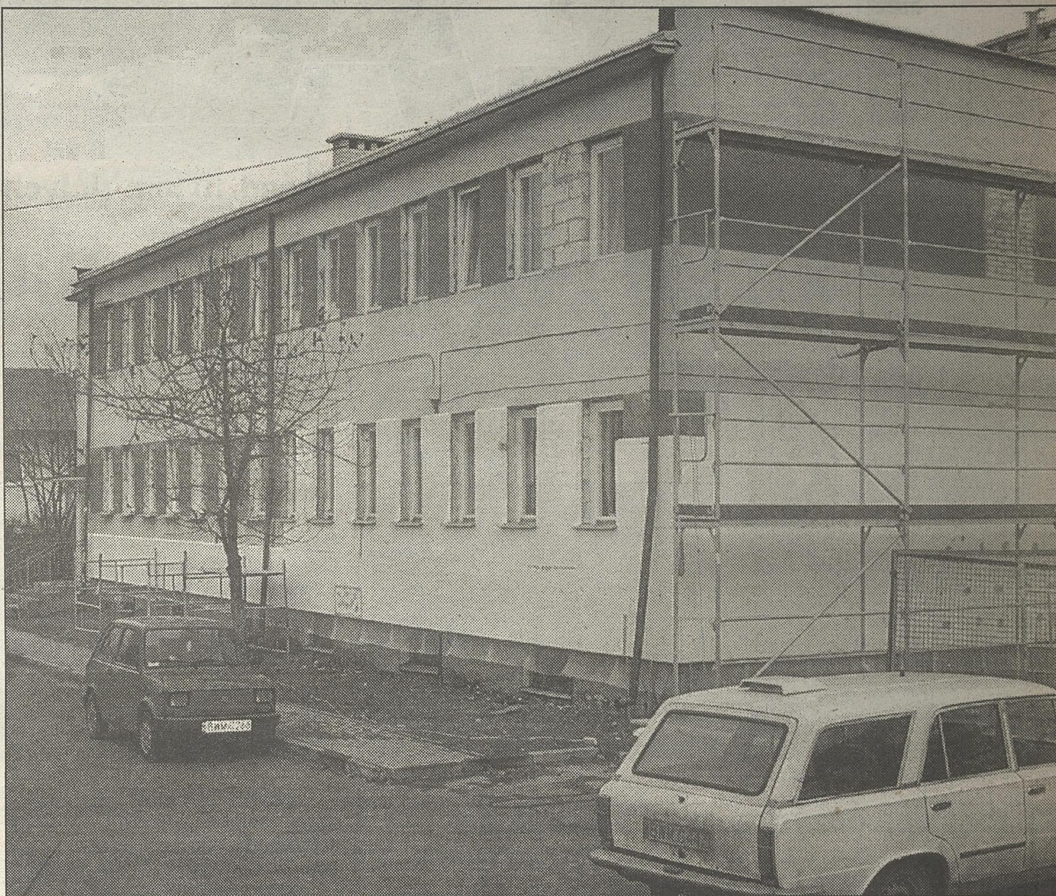
W budynku przy ul. Białostockiej trwa wykończanie elewacji
