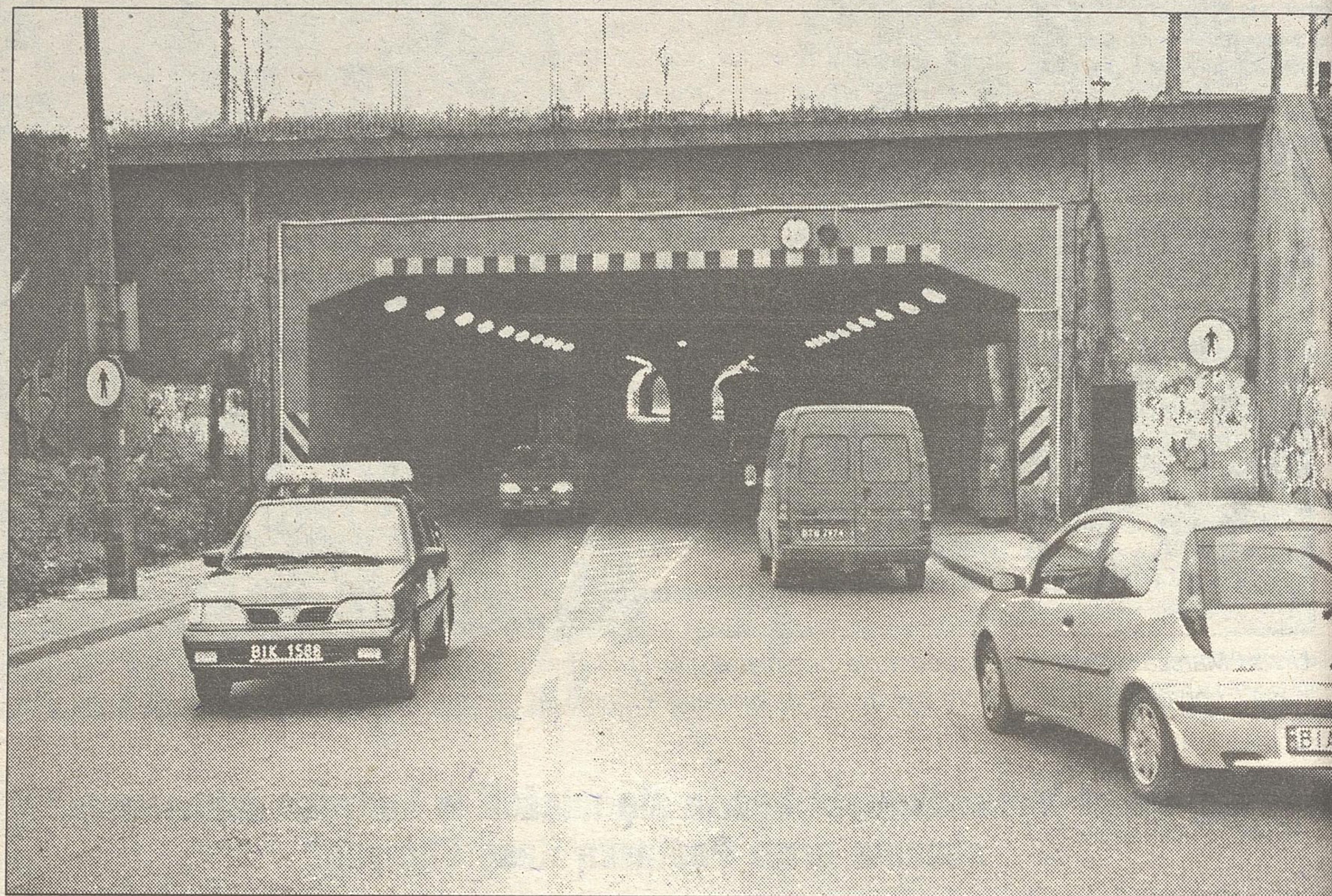
Obligacje gminne pozwolą na sfinansowanie m.in. budowy nowego tunelu łączącego ulice Popiełuszki i Składową
