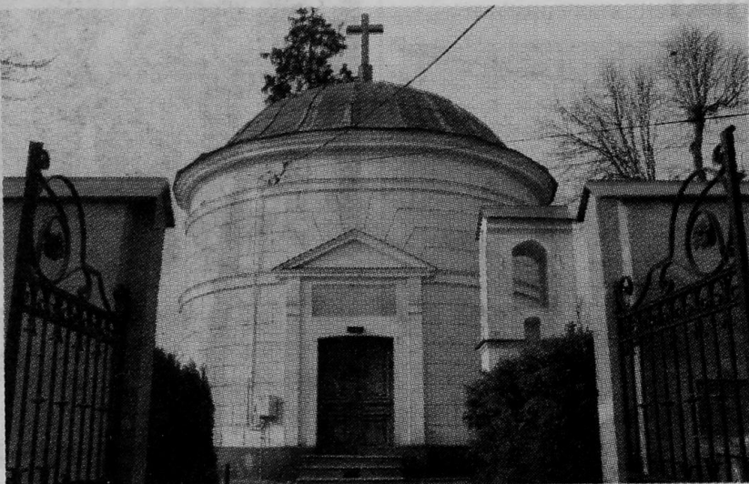
Kaplica Śmiarowskich czeka na generalny remont
