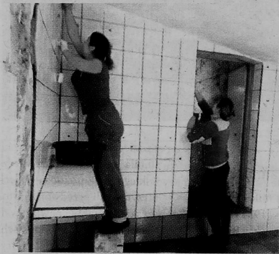
Maj, malowanie pomieszczenia gospodarczego, tymczasowej siedziby Koła
