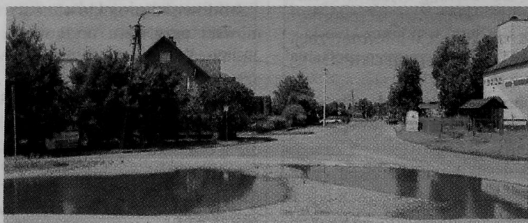
Droga ze Srebrnej do Łętownicy będzie w tym roku przebudowana
