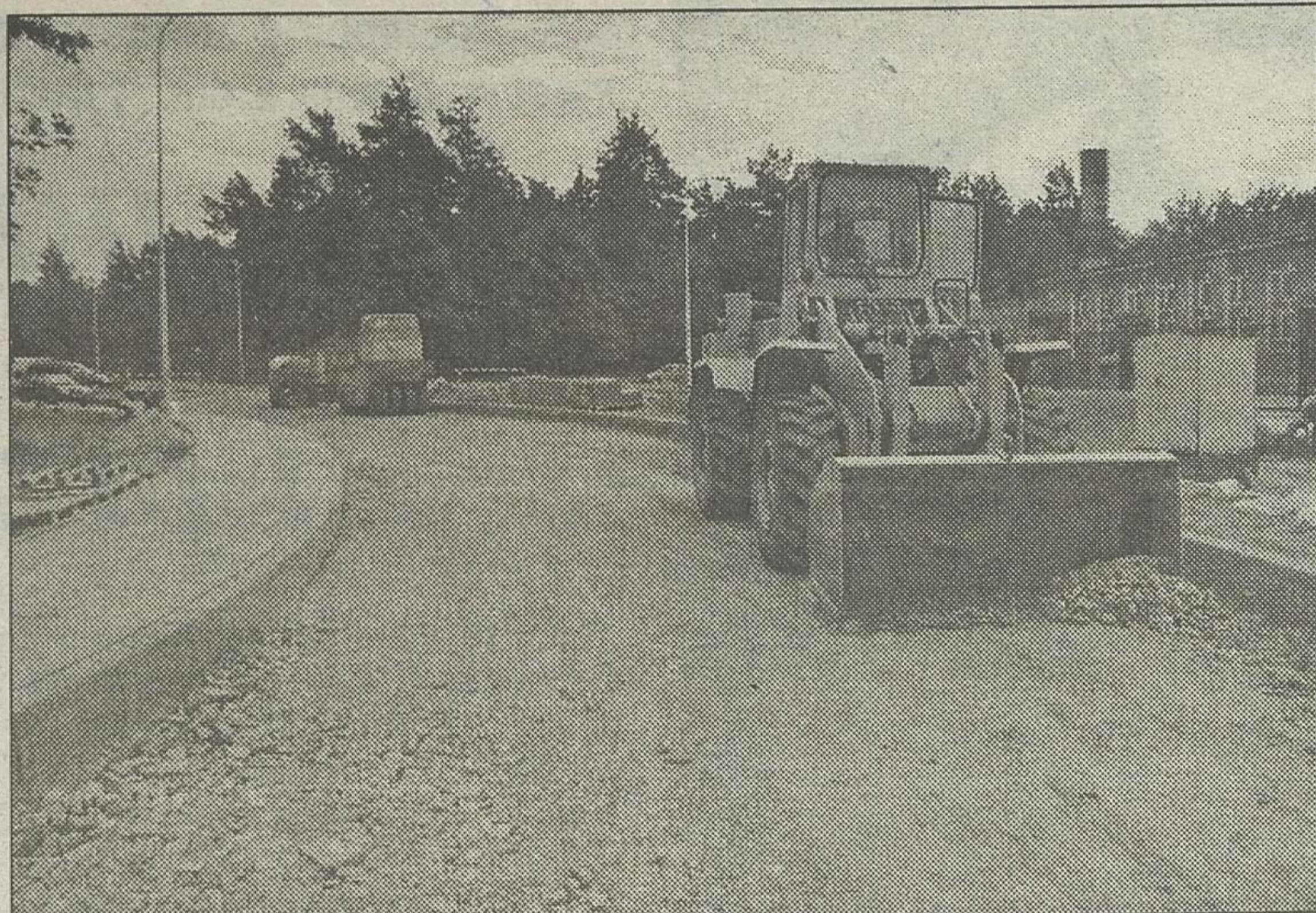
Trwa budowa ostatniego odcinka ul. Sławińskiego
