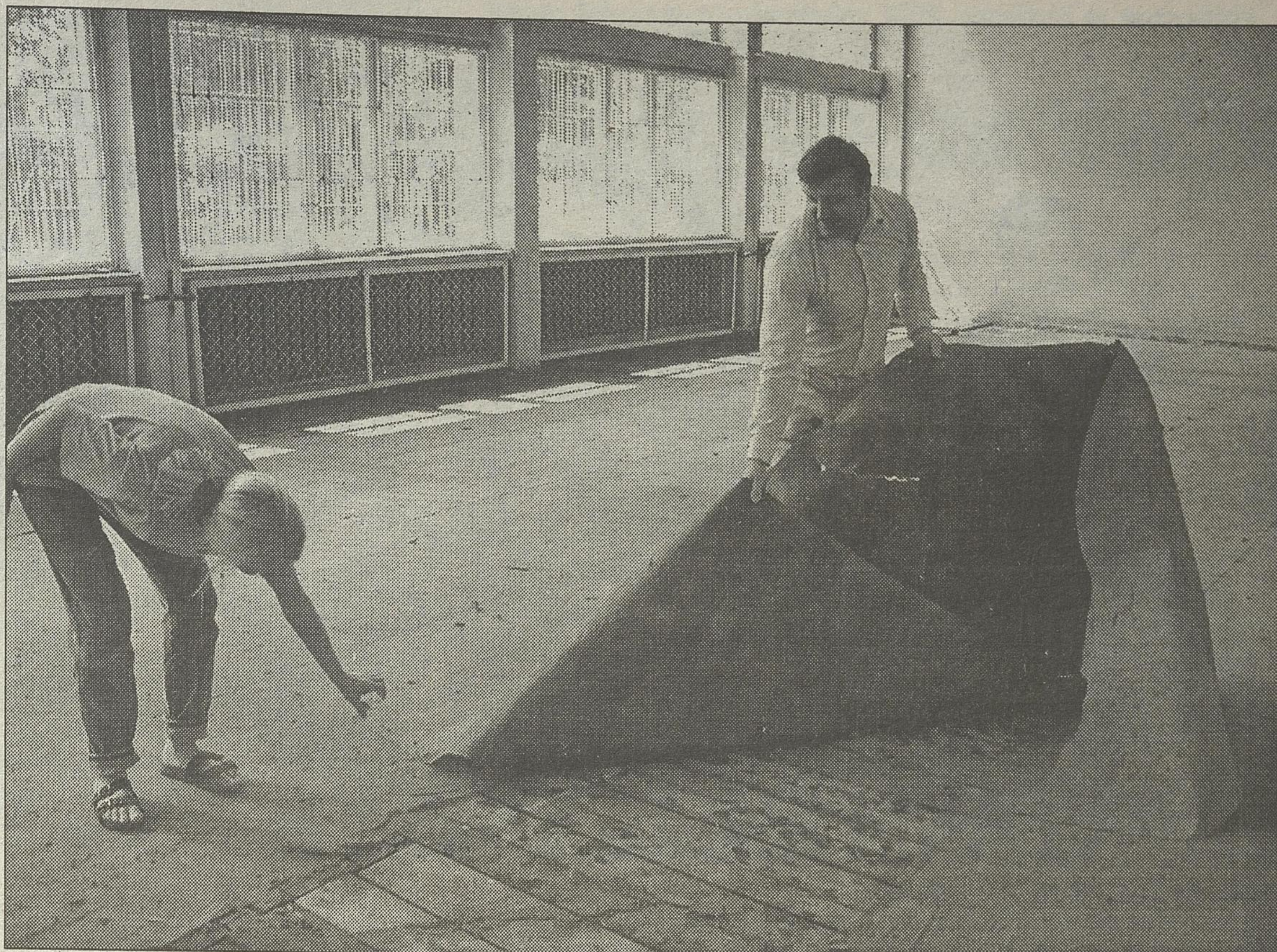
Trwa modernizacja szkolnego budynku przy ul. Antoniuk Fabryczny 1
