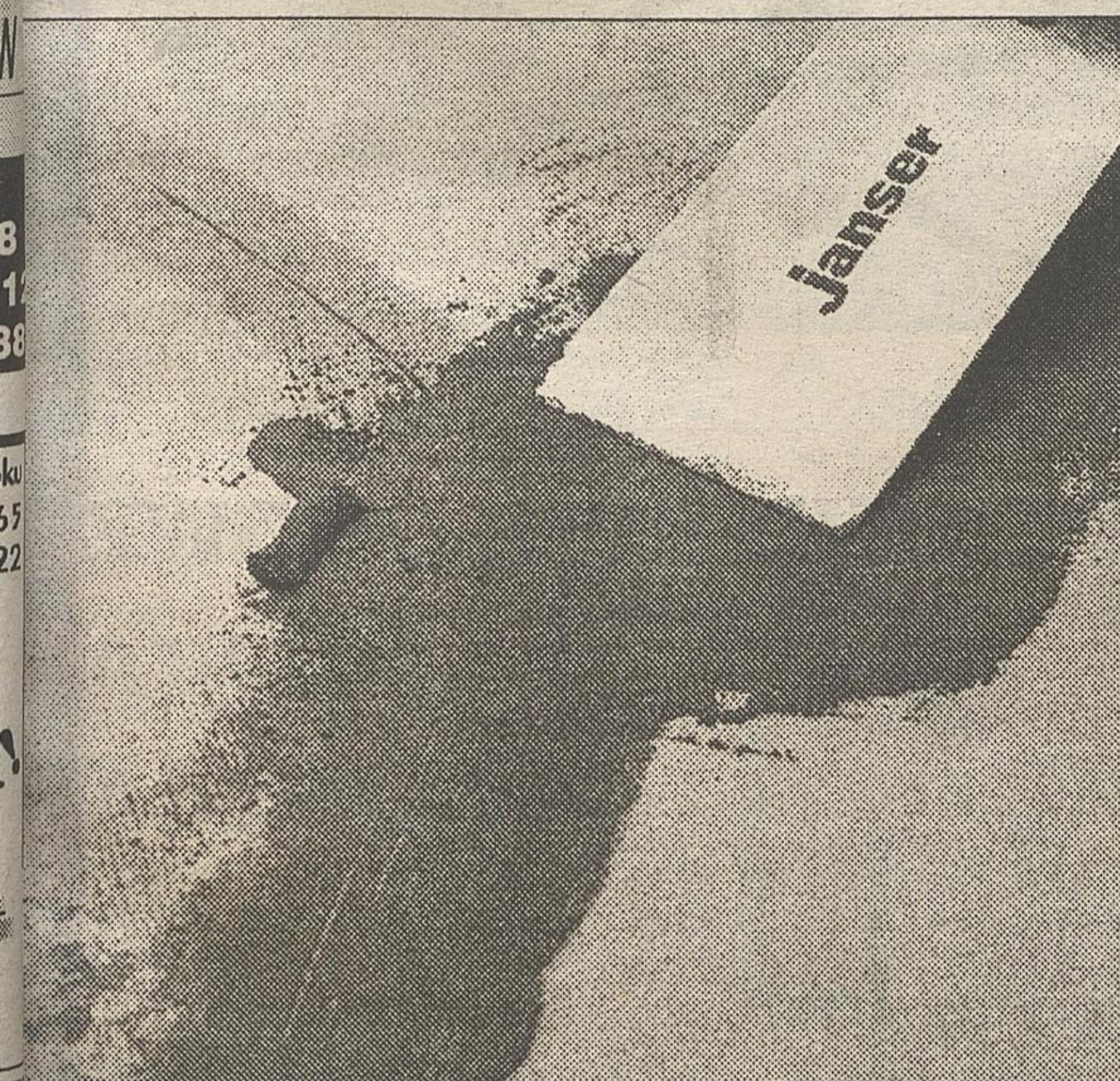
Jeśli rysy są niewielkie, można wypełnić je masą mineralną, tą samą, z której zrobimy wylewkę
