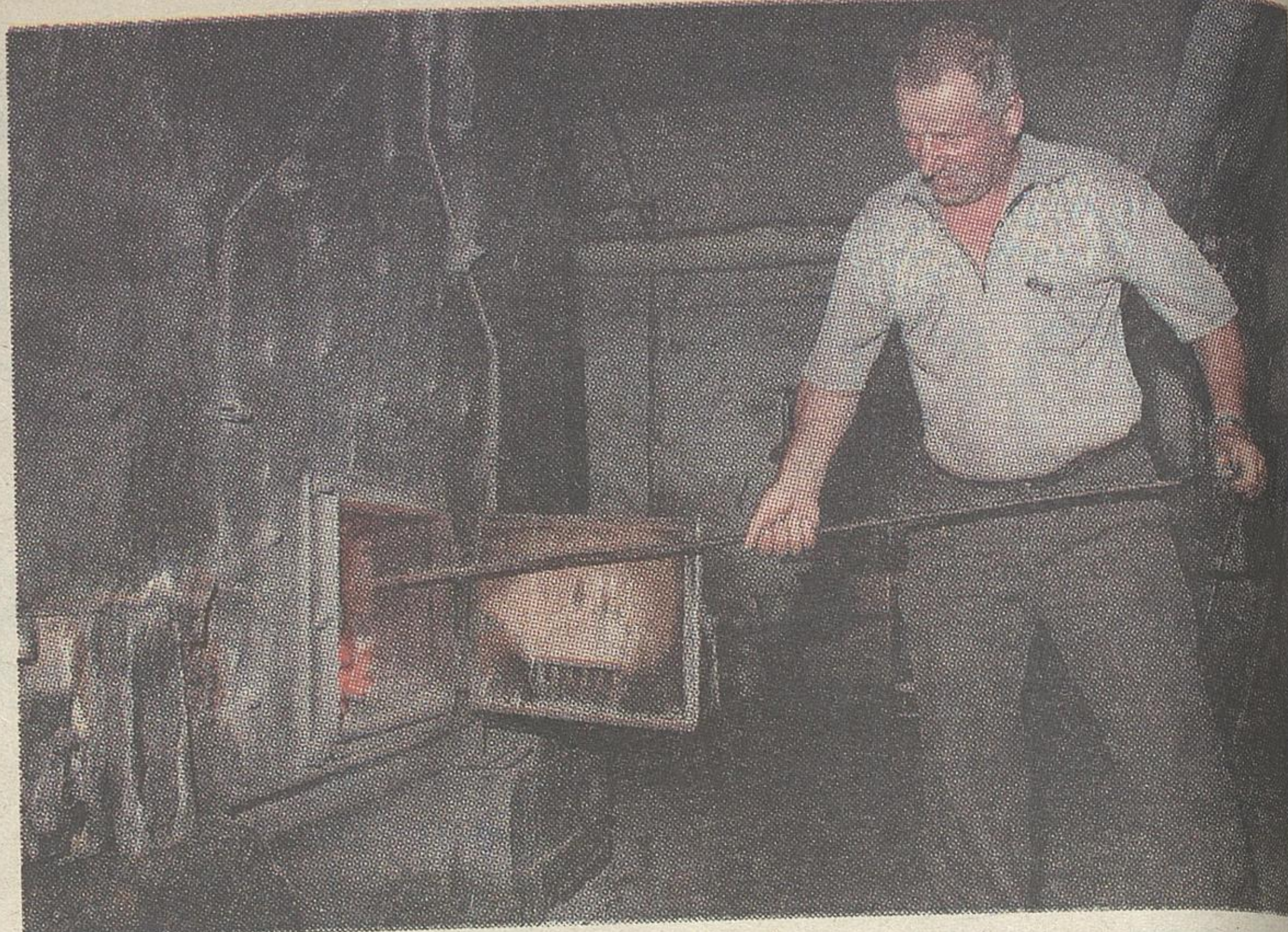
Stara kotłownia od dawna wymaga remontu.
