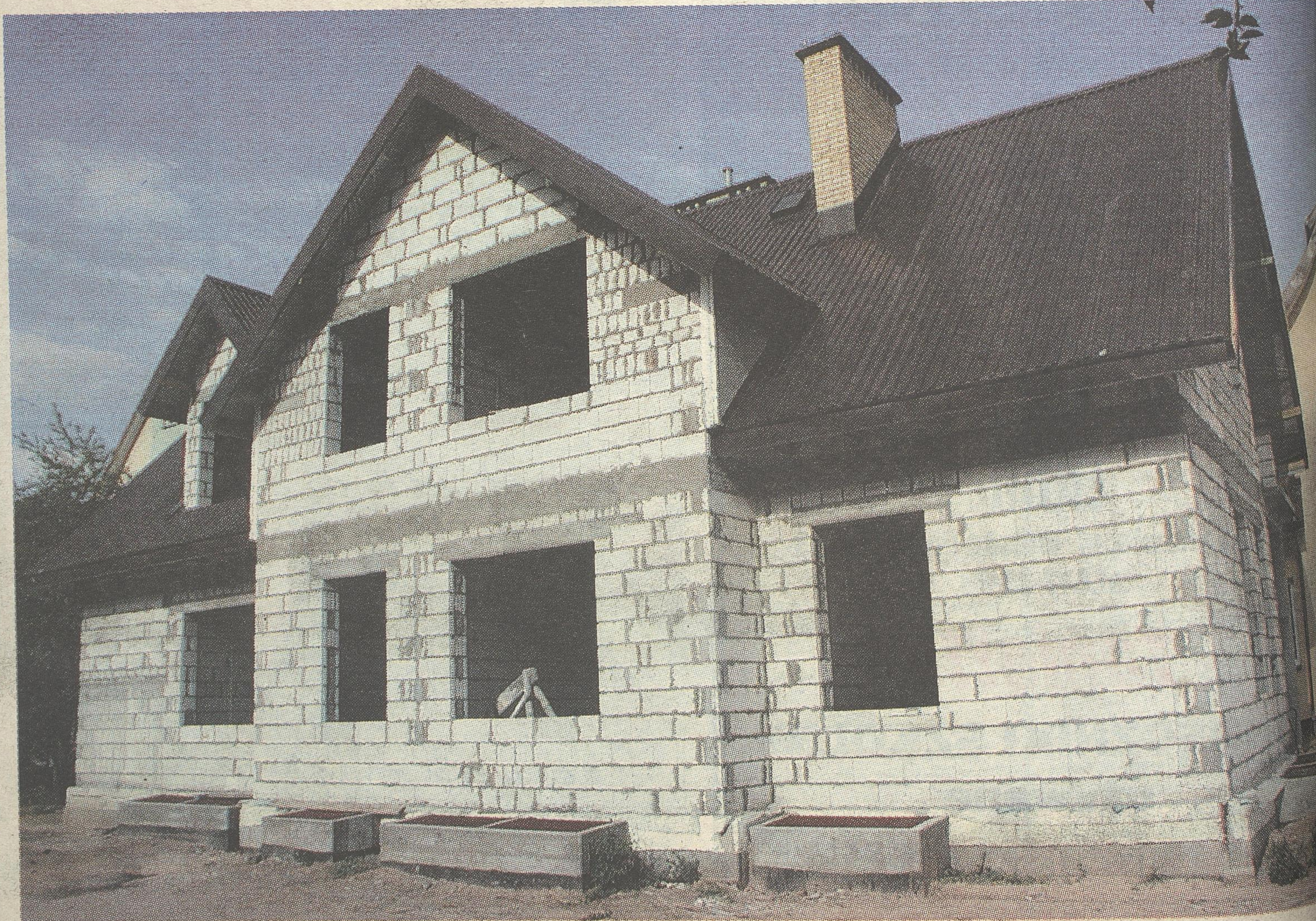
W Augustowie odbywa się budowa i modernizacja dwóch domów opieki społecznej.
