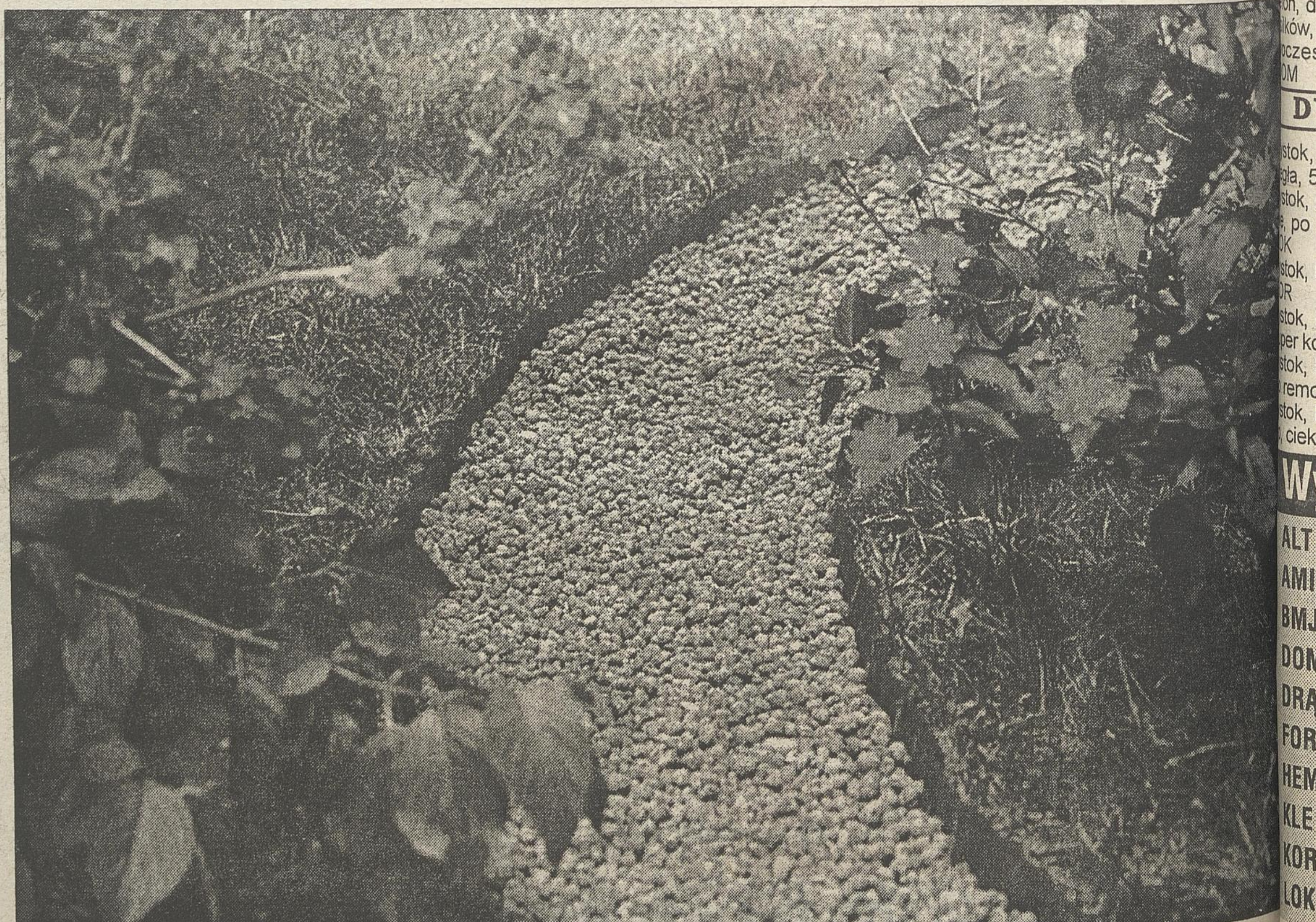
Z keramzytu można wykonać doskonałą podbudowę pod ścieżkę ogrodową
