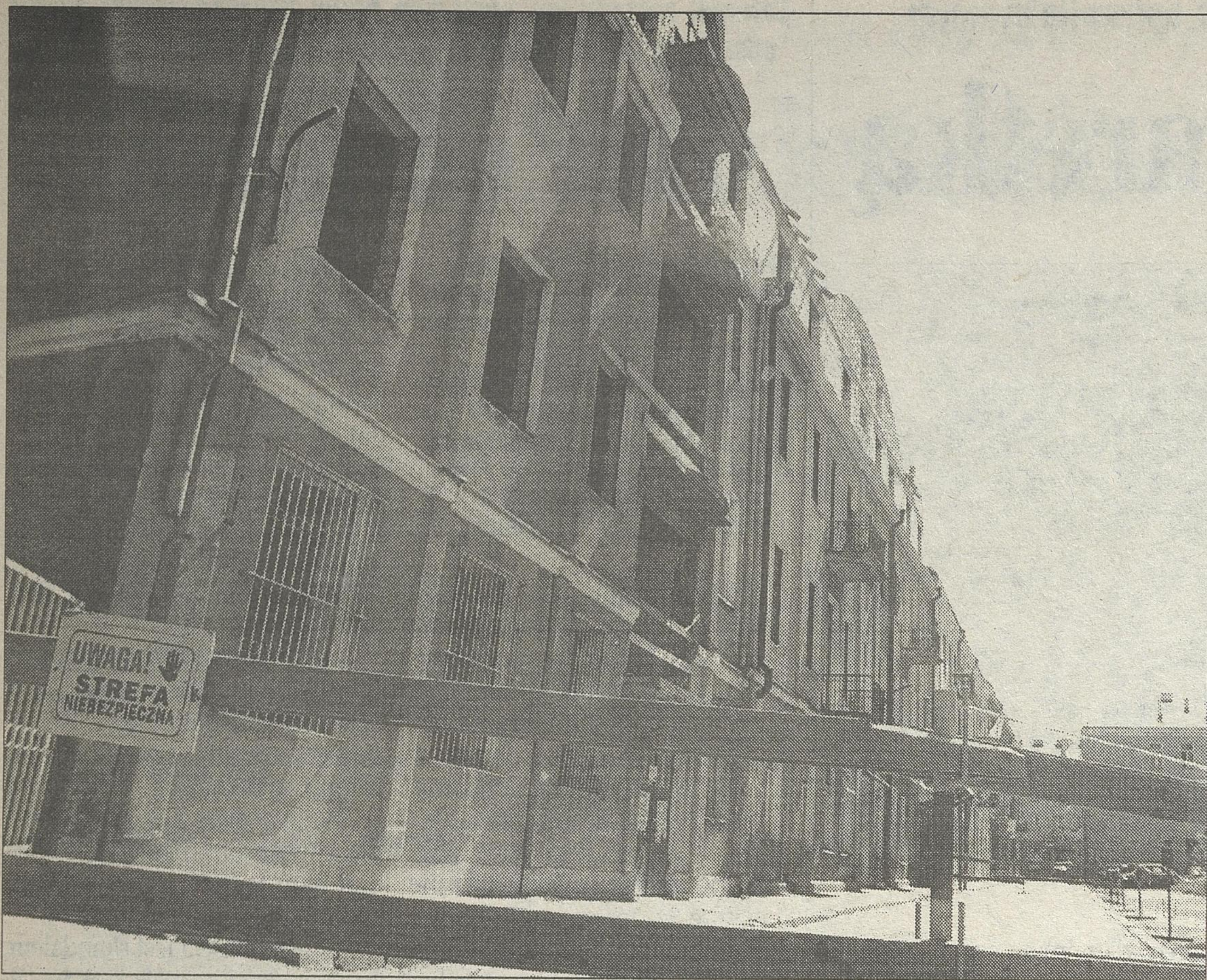
Po remoncie w kamienicy przy ul. Przejazd mieścić się będą lokale usługowo-handlowe i biurowe
