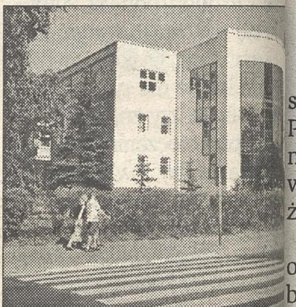
Dzięki remontowi budynek Centrum Krwiodawstwa zyska nowoczesny wygląd
