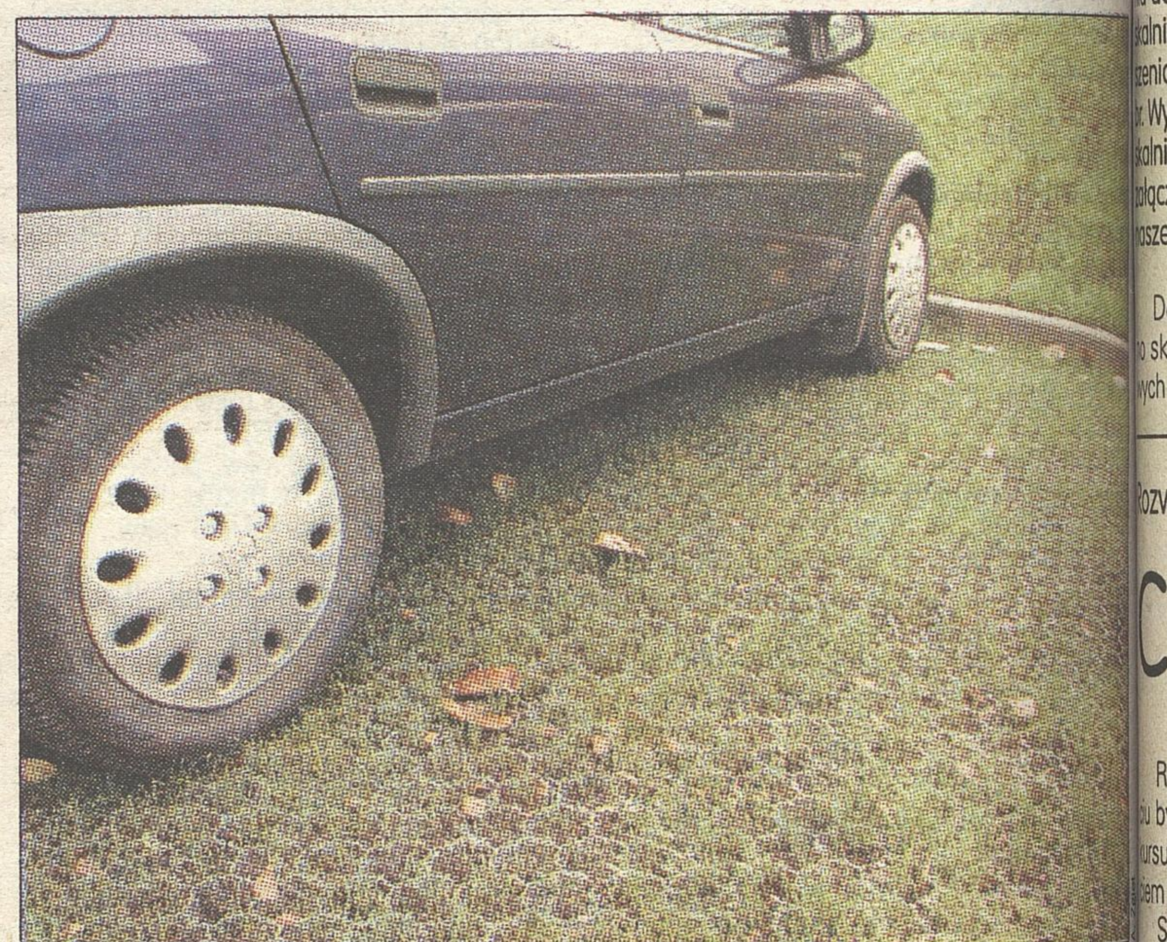
Nawierzchnia typu ekoplaster wzmocni każdy trawnik. Nawet w miejscu parkowania samochodów nie będzie pustych miejsc
