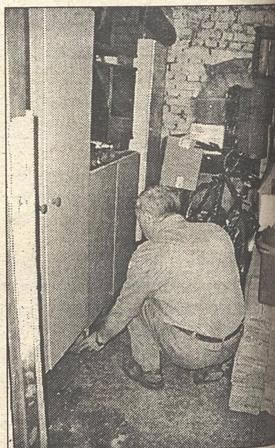
Rzeczy przechowywane w piwnicy ustawione są na ceglach
