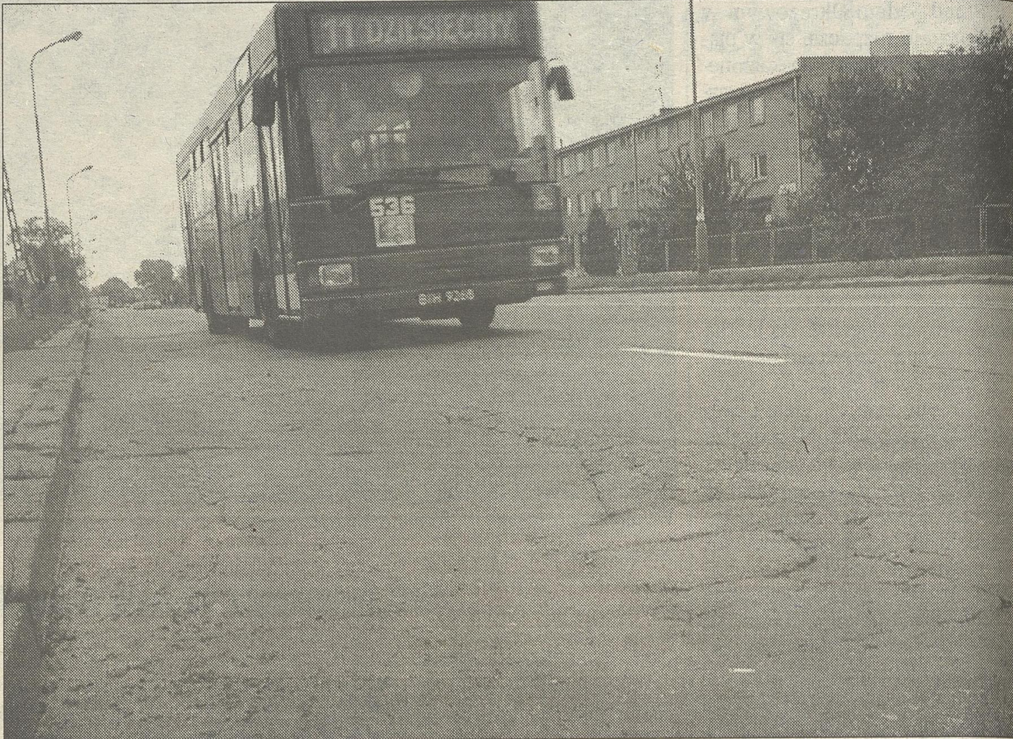
Wśród ambitnych zamierzeń inwestycyjnych, znajduje się m.in. remont zniszczonej ulicy Hetmańskiej
