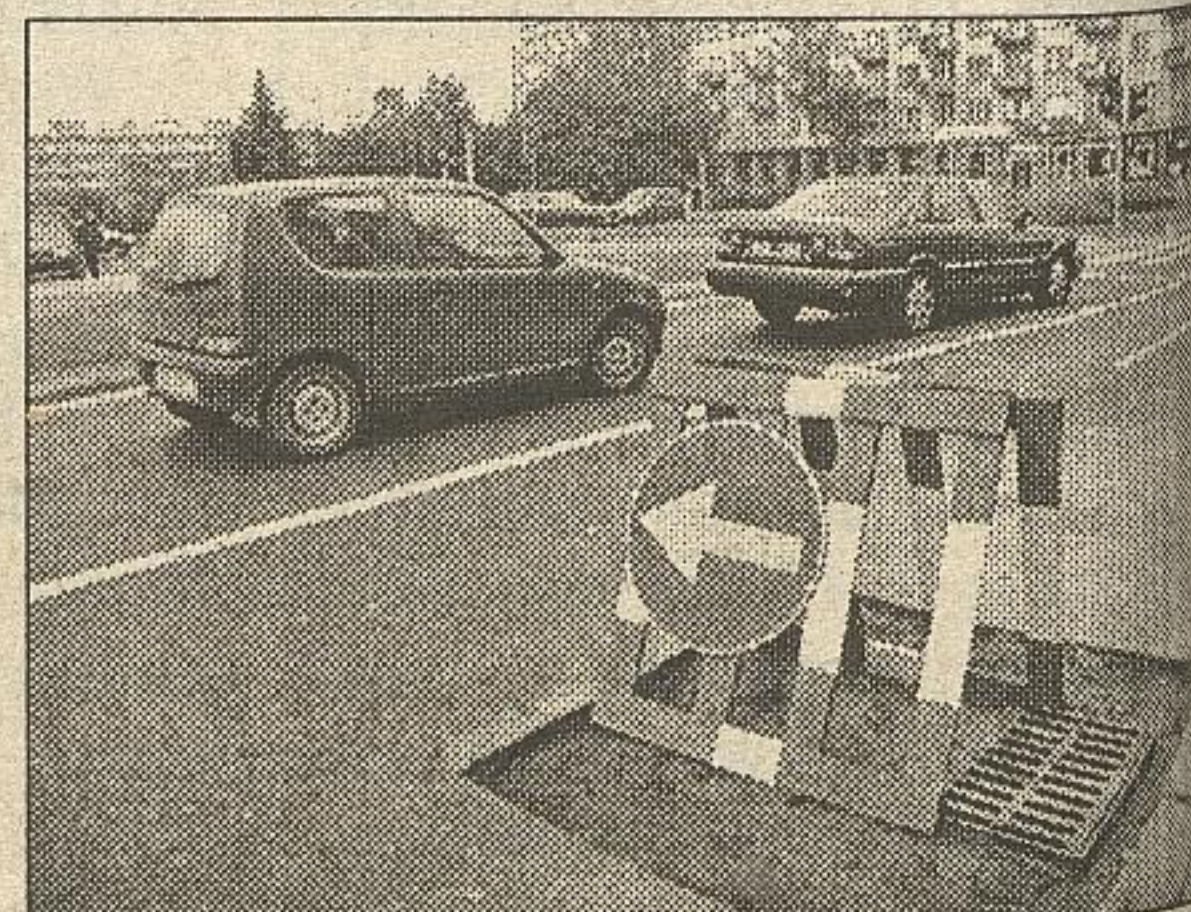
Prace na placu potrwać jeszcze kilka dni
