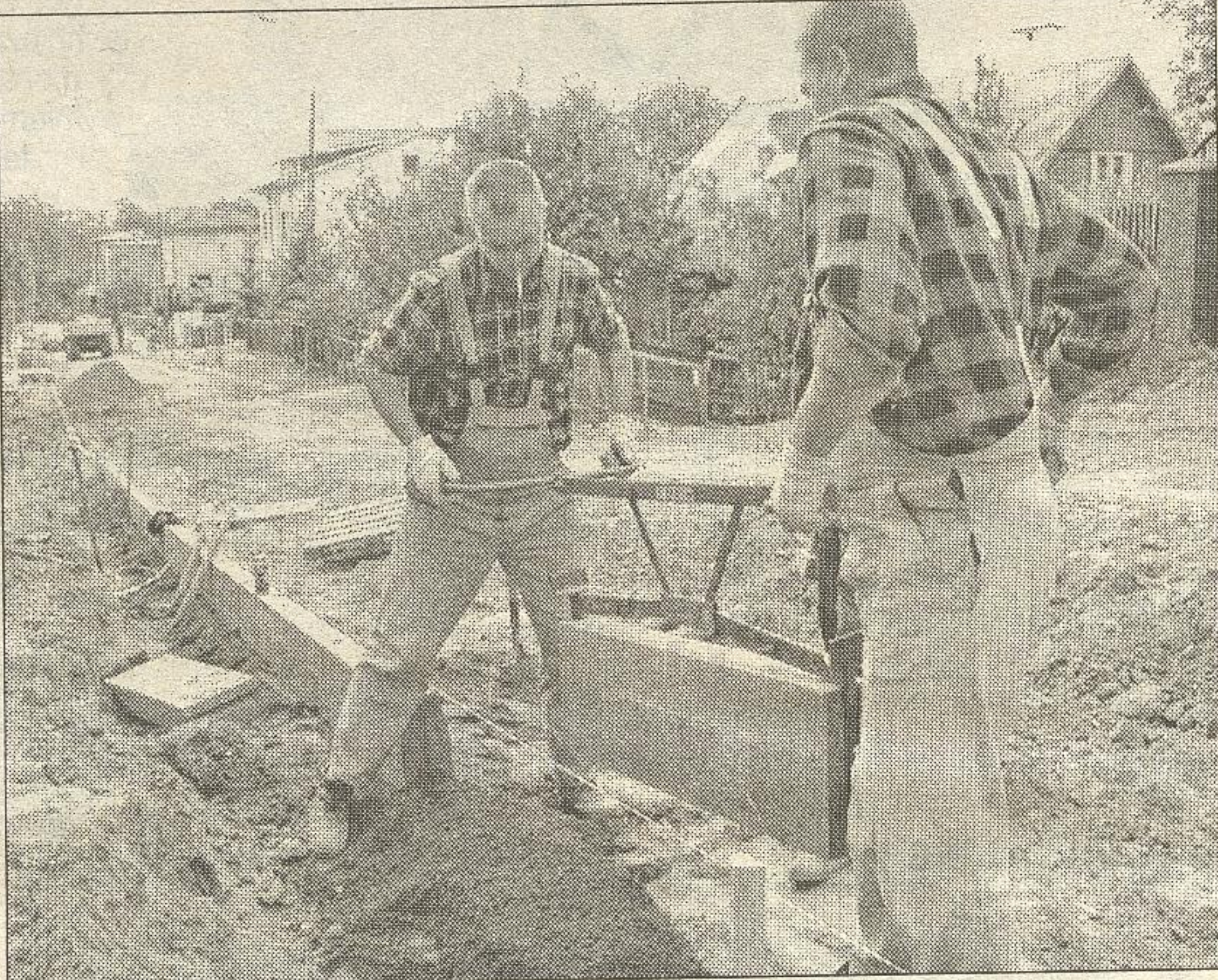
Najwięcej dróg w tym roku zbudowano na osiedlu Wygoda (na zdjęciu prace na ul. Żwirowej)
