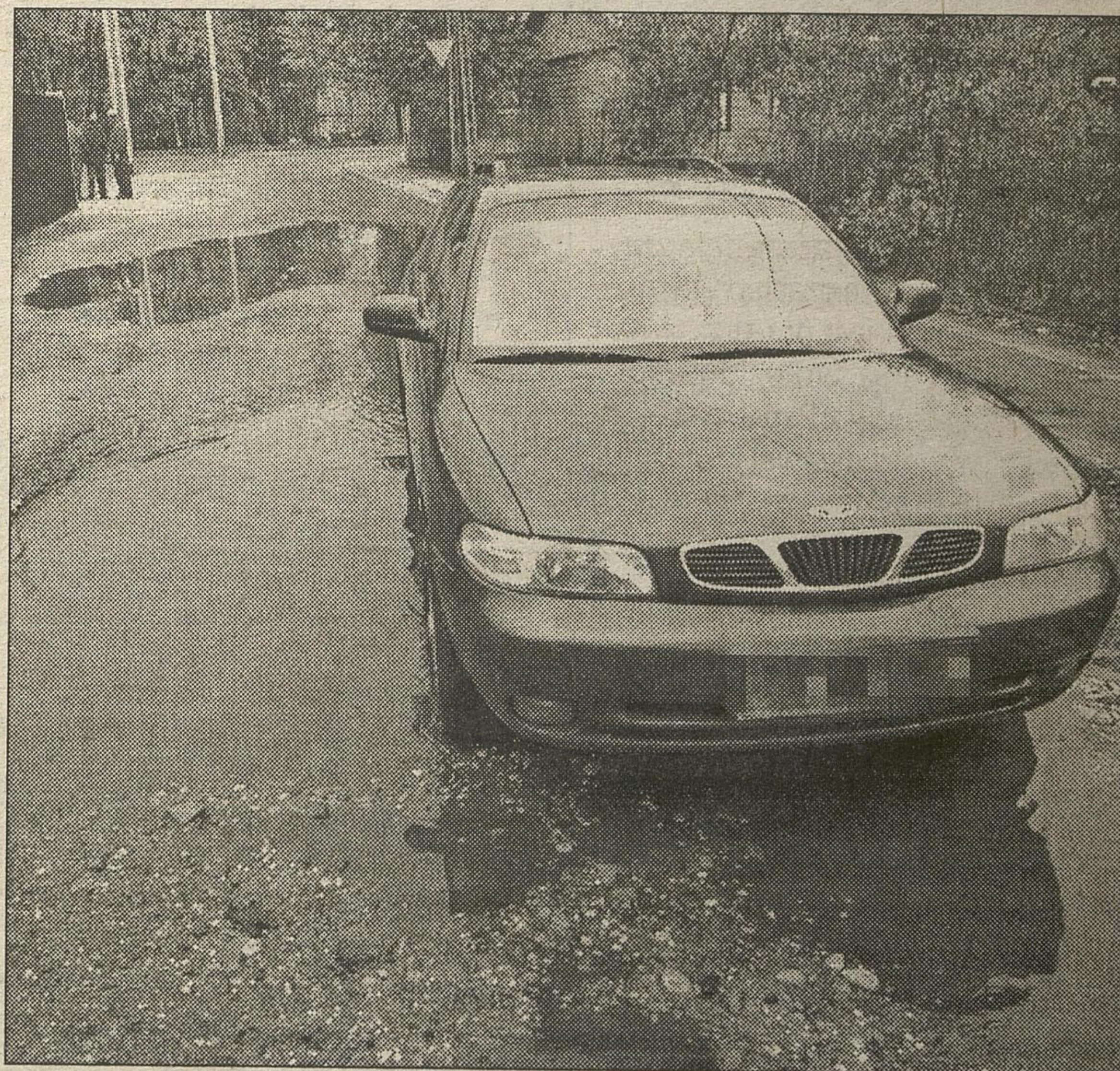
Po opadach deszczu trudno przejechać przez ulicę Cedrową
