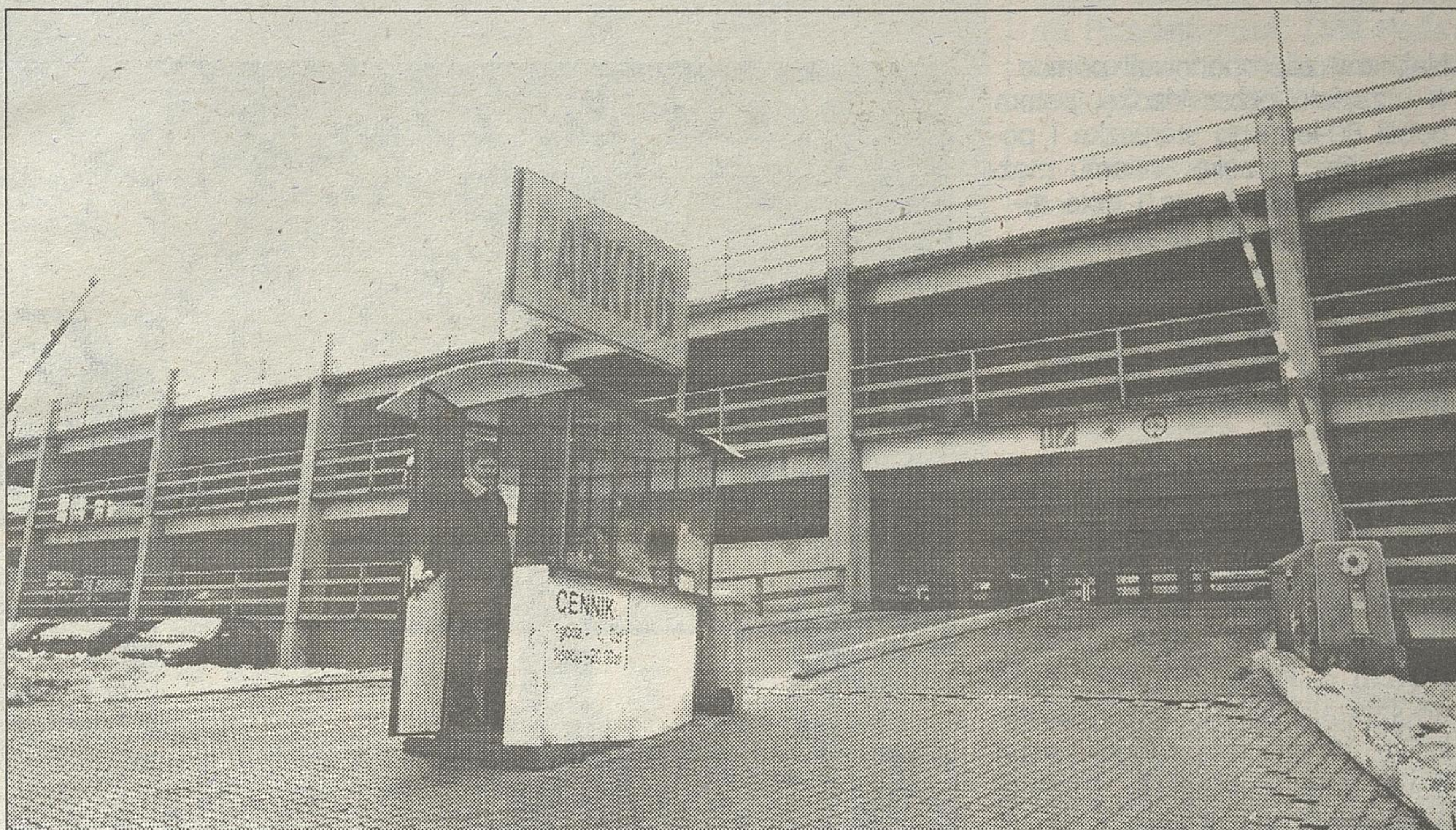
Jedyny wielopoziomowy parking z prawdziwego zdarzenia znajduje się przy Hotelu Gołębiowski
