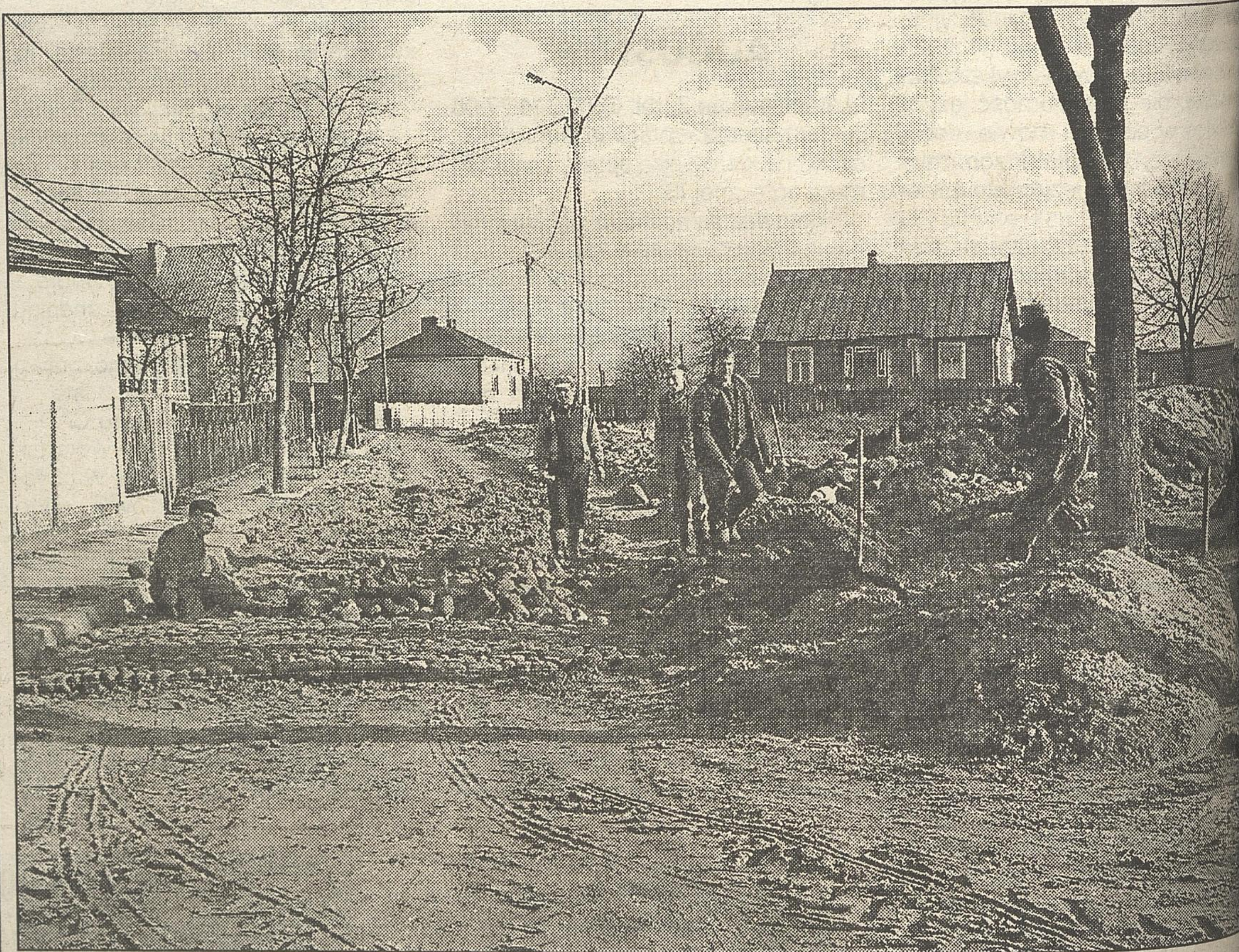
Układanie nawierzchni brukowej przy ulicy Sienkiewicza
