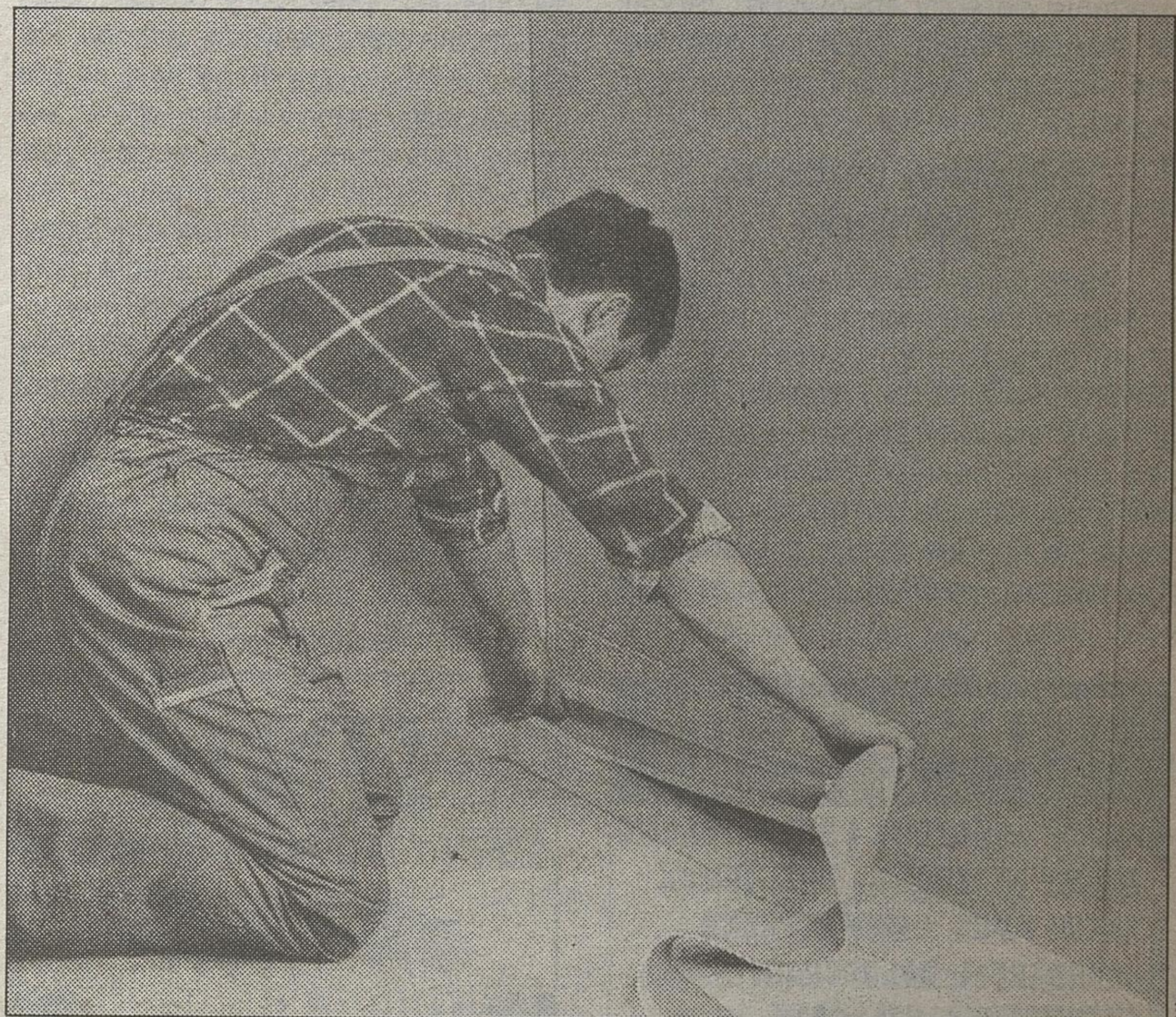
Wklejanie taśmy uszczelniającej w rozprowadzoną masę
