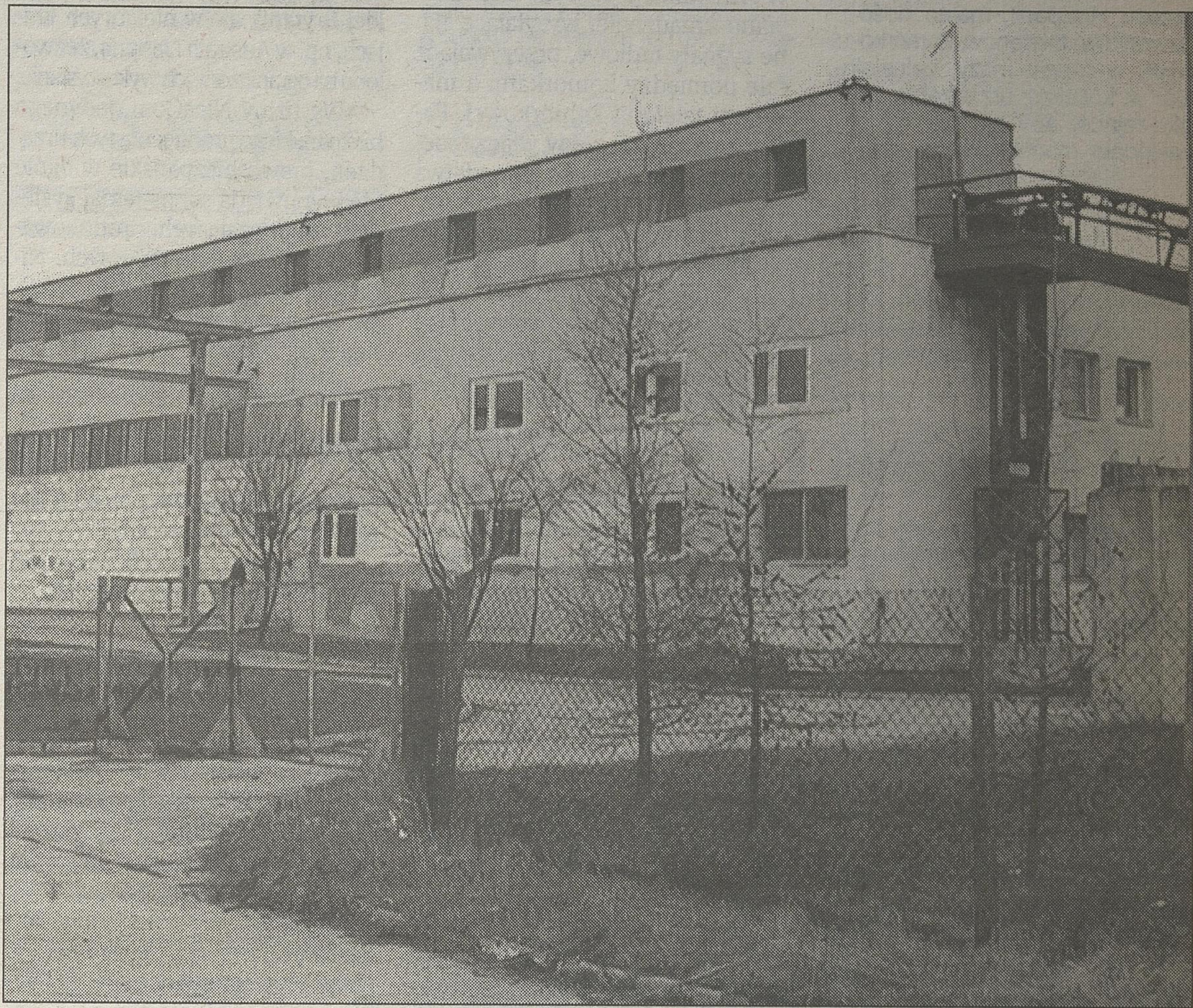
Jeszcze w tym roku w budynku dawnej kotłowni powstanie Centrum Kształcenia Zawodowego
