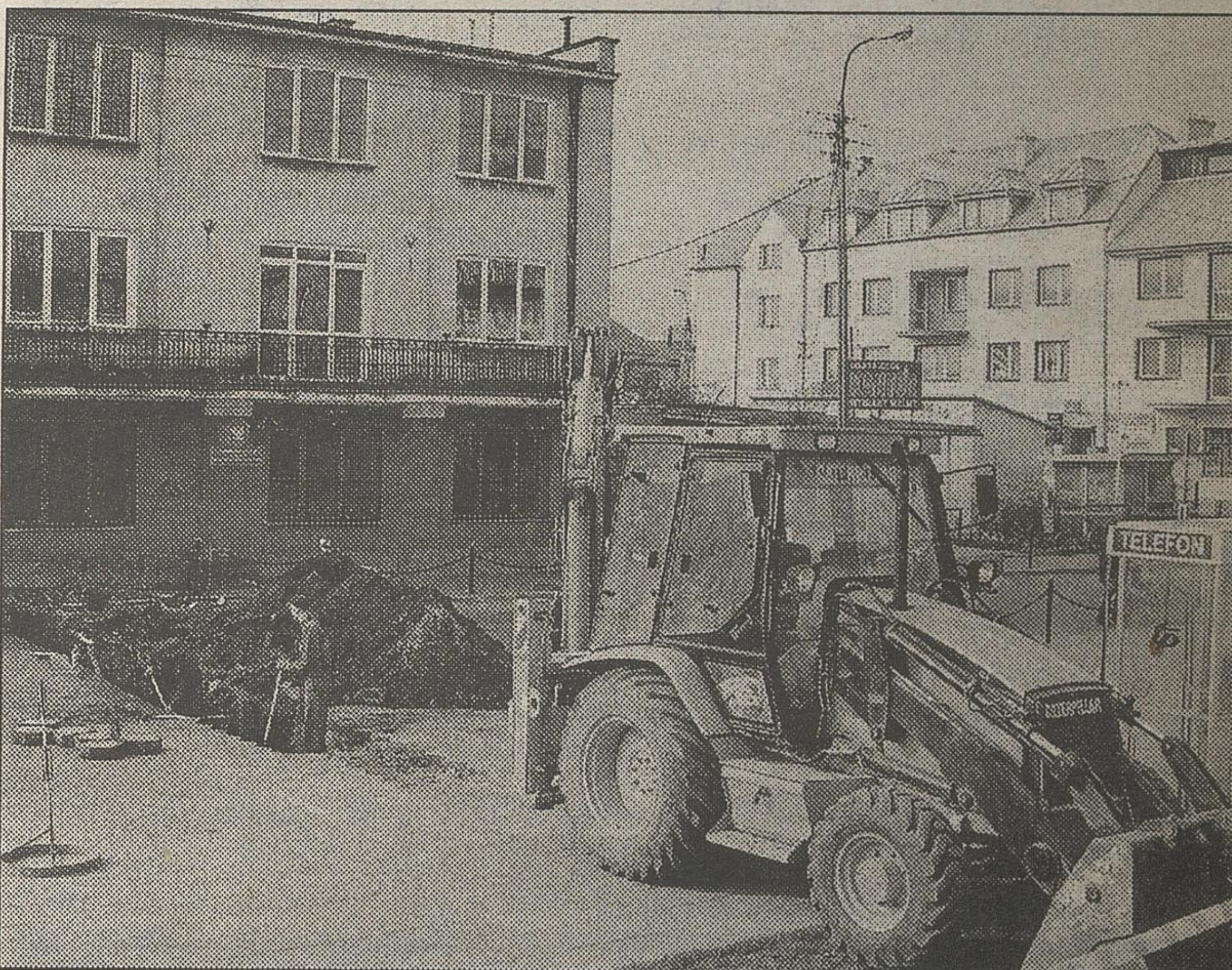
Podłączanie budynku łapskiej policji do miejskiej sieci ciepłowniczej
