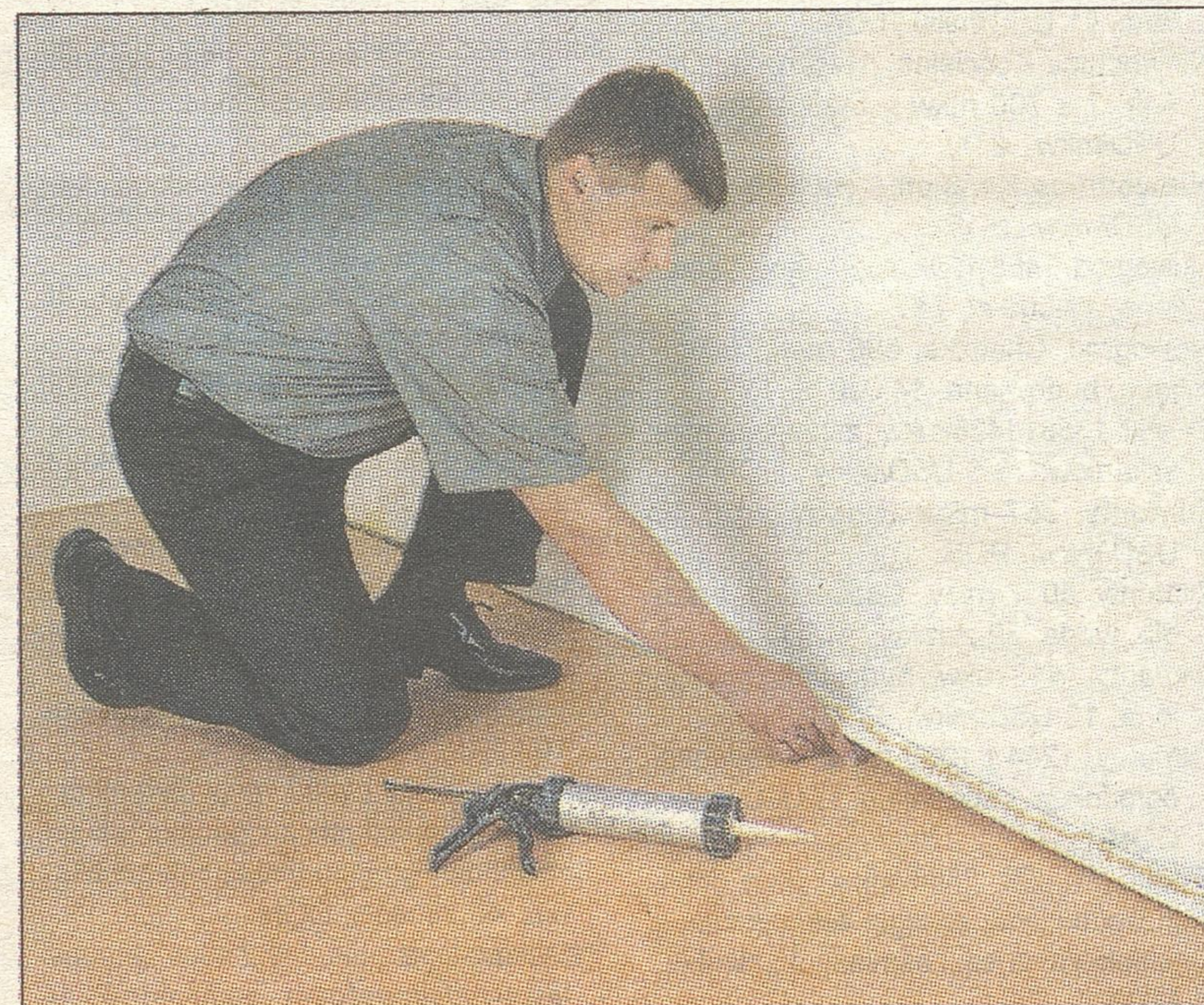
Silikon przydatny jest przy doklejaniu listew na brzegach wykładziny
