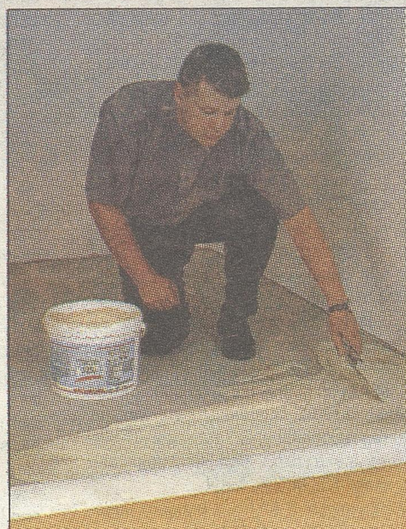
Ważne jest równomierne rozprowadzenie kleju, którym przytwierdzamy wykładzinę do podłogi
