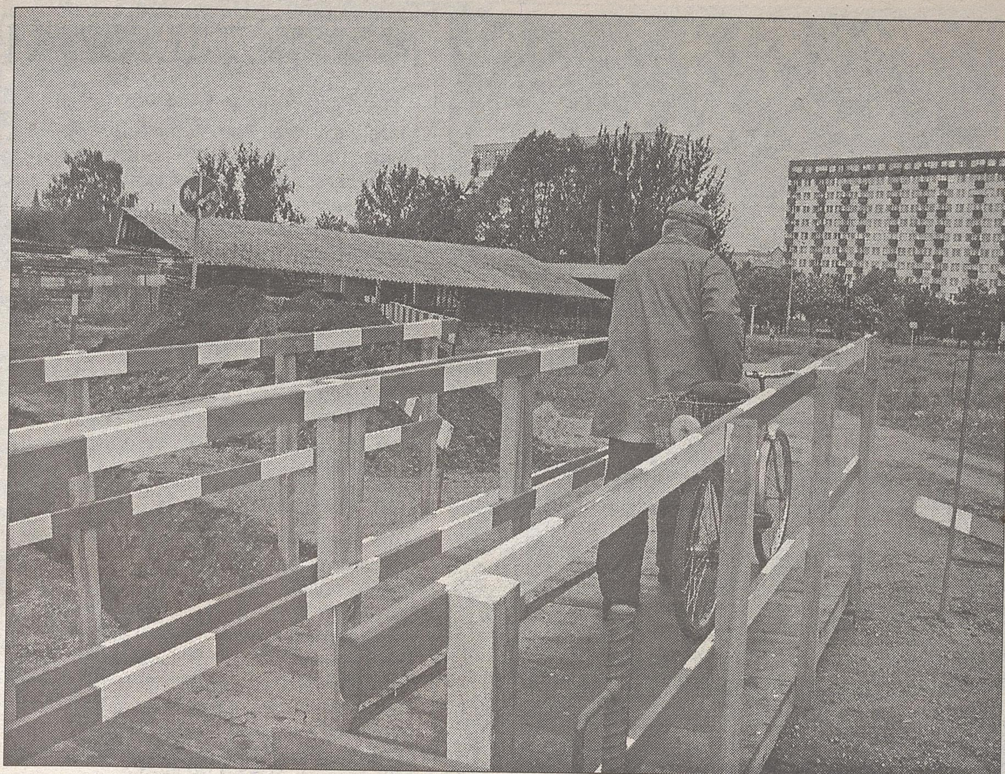
Prace budowlane spowodowały konieczność rozkopania ścieżki rowerowej
