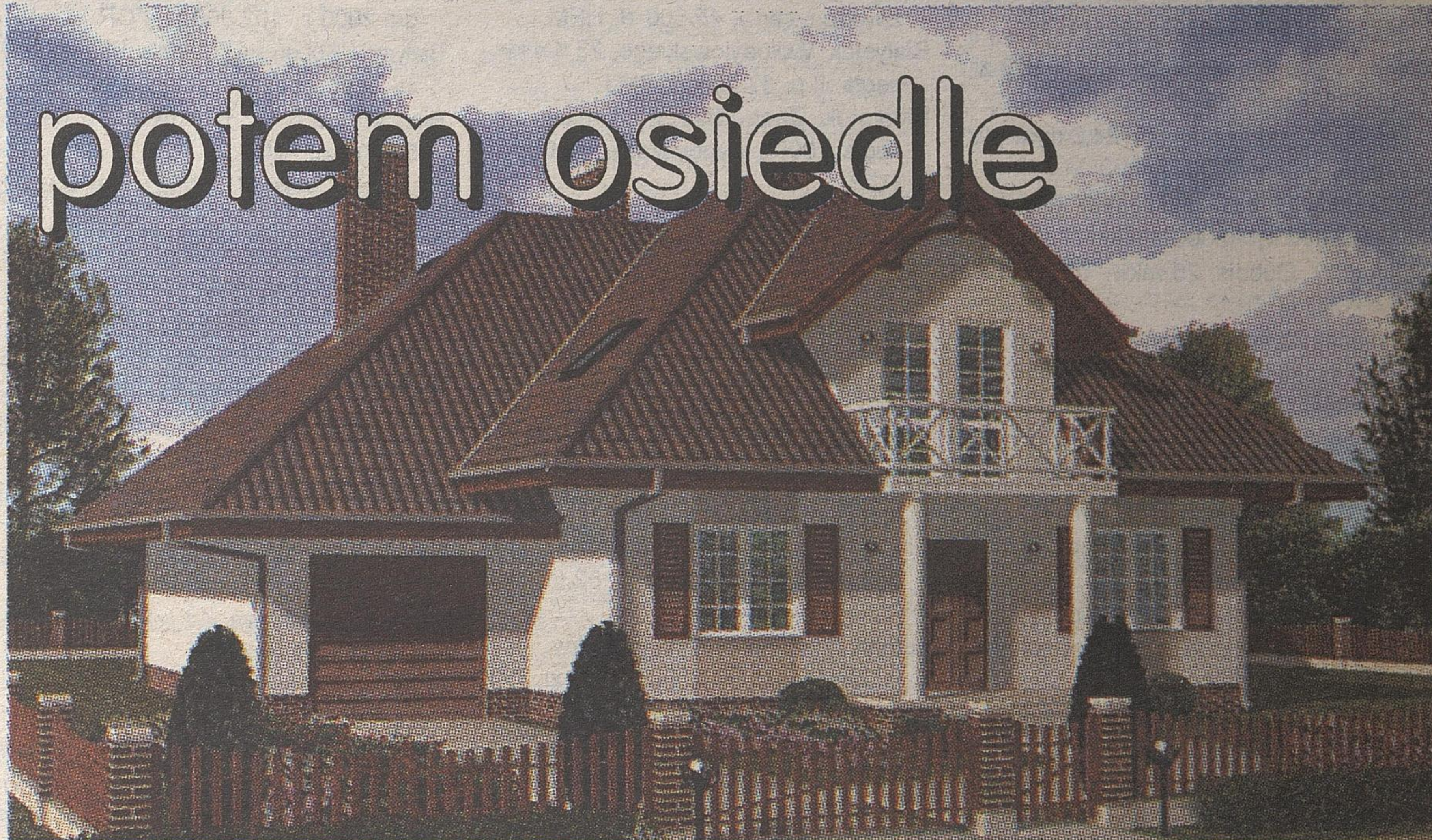
Tak będzie wyglądał dom, który jest właśnie budowany w technologii szkieletowej na działce w Czarnej Białostockiej
