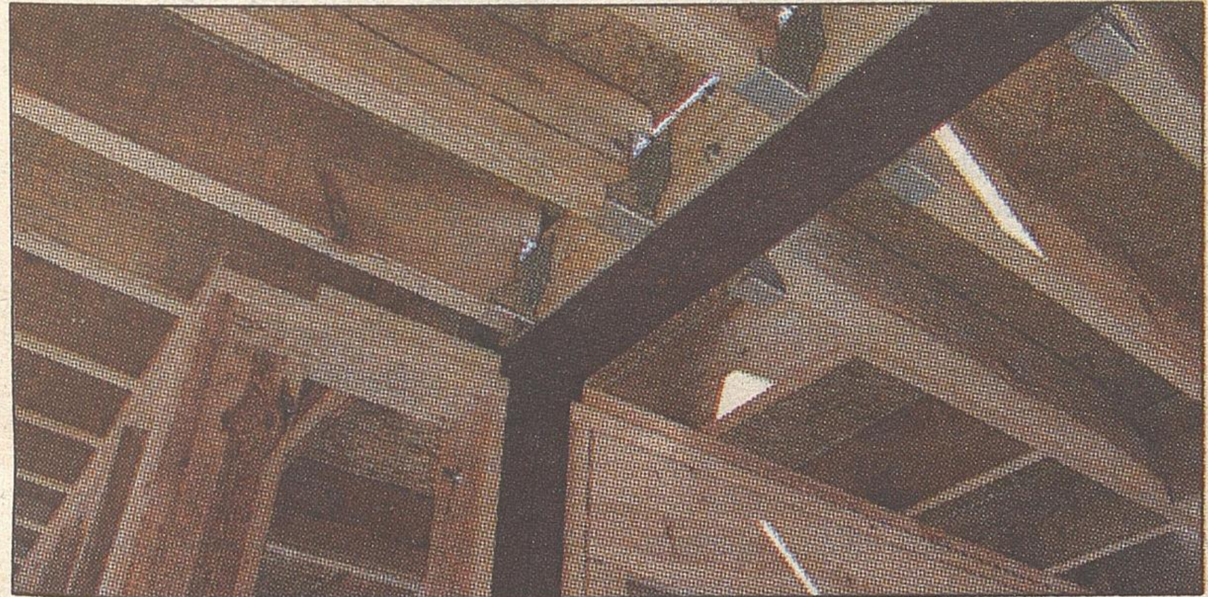
Poszczególne drewniane belki szkieletu domu są łączone za pomocą metalowych obejm i gwoździ
