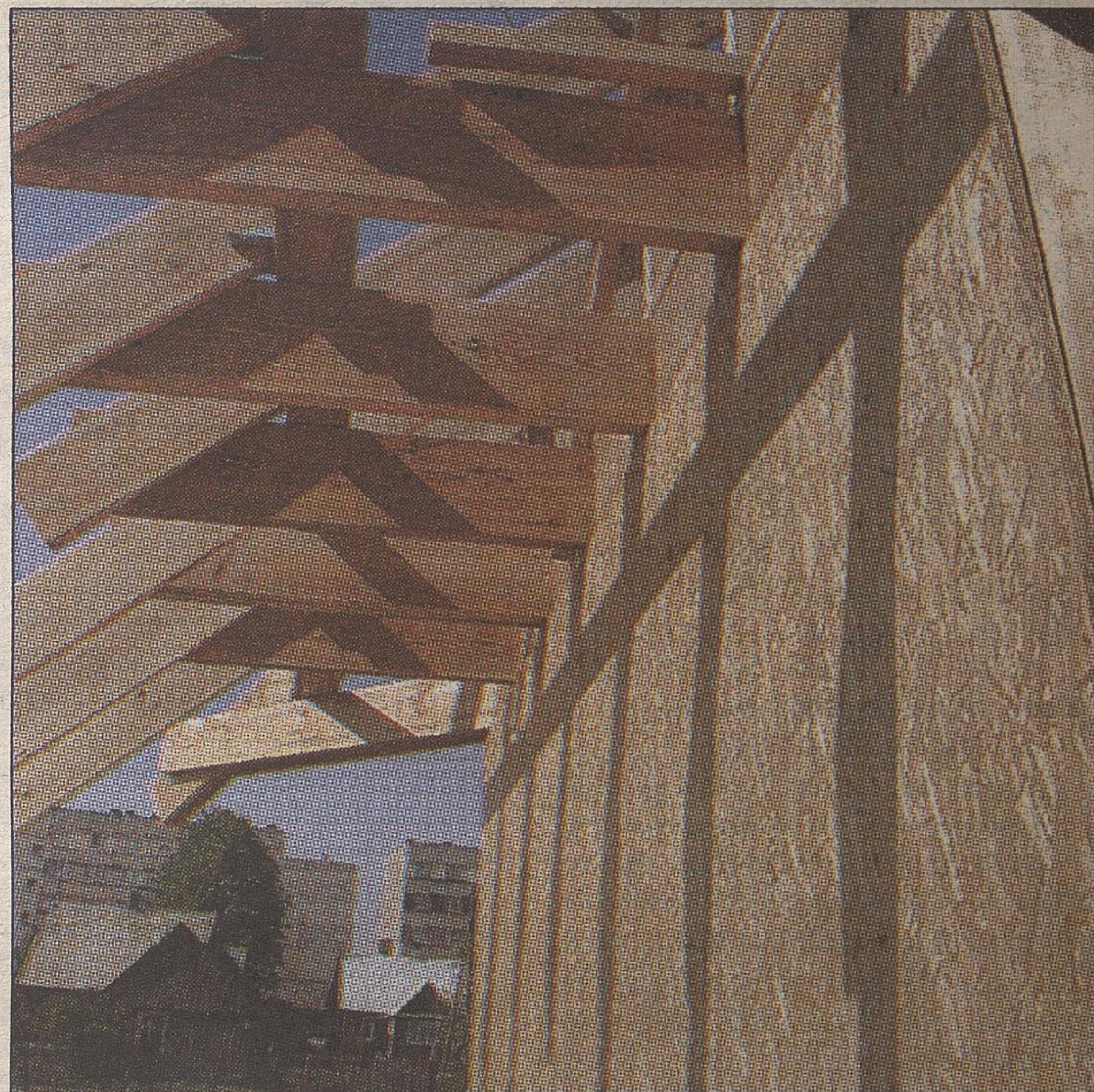
Podłogę pod ściany gipsowo-kartonowe stanowią wodoodporne płyty paździerzowe
