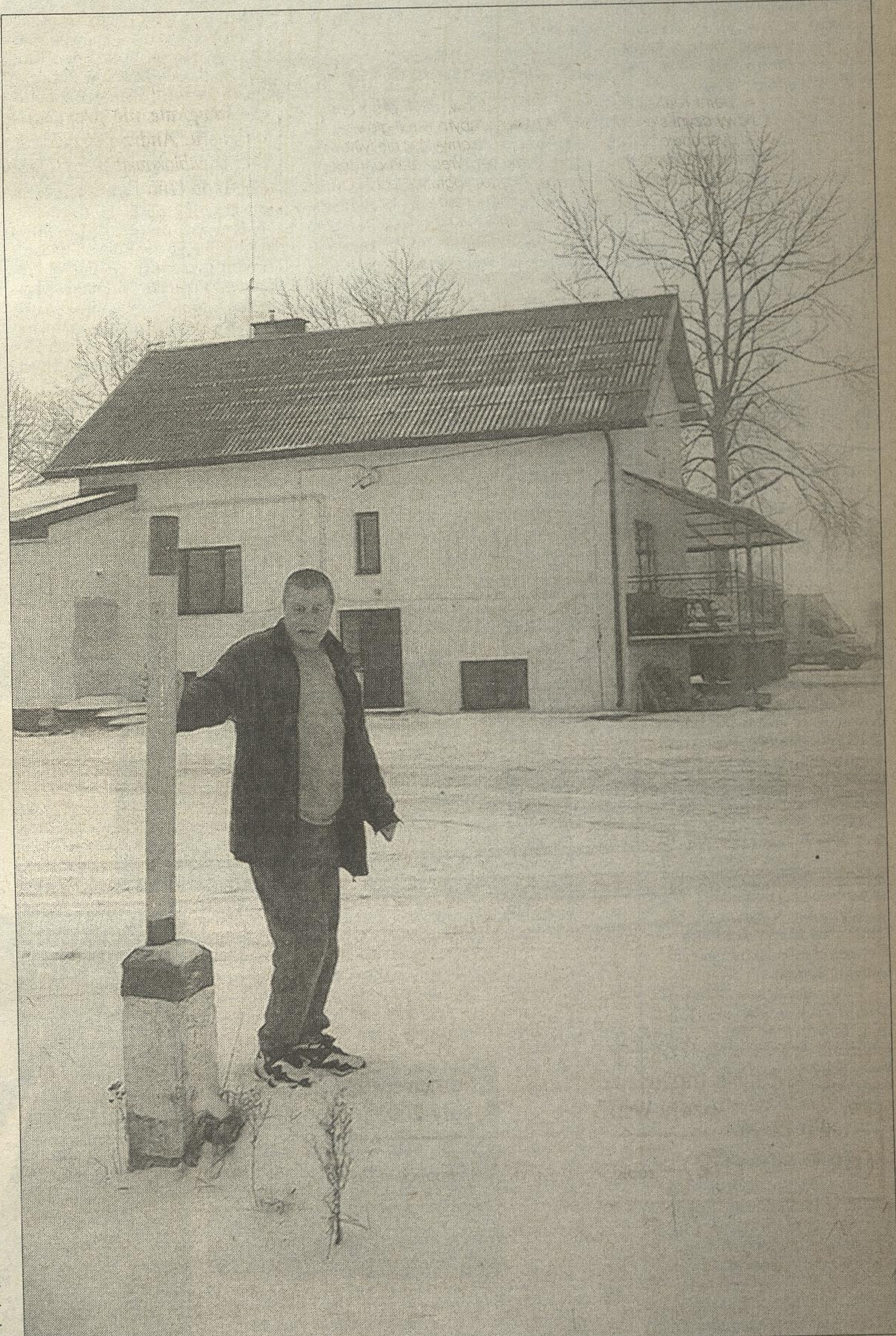
Słupek oznaczający przebieg gazociągu na posesji Wiesława Kowalczyka został przez właściciela posesji przesunięty, aby nie utrudniał poruszania się po działce. W rzeczywistości rura przebiega w odległości 14 m od wiodącej w głąb budynku restauracji. PGNiG w jednym z wariantów rozwiązania problemu proponuje dodatkowe zabezpieczenie rury, zmniejszenie strefy wolnej do 3 m z każdej strony oraz utworzenie kilku przejazdów przez gazociąg. Wówczas, w opinii właściciela gazociągu, działka mogłaby być wykorzystana w 90 procentach.
