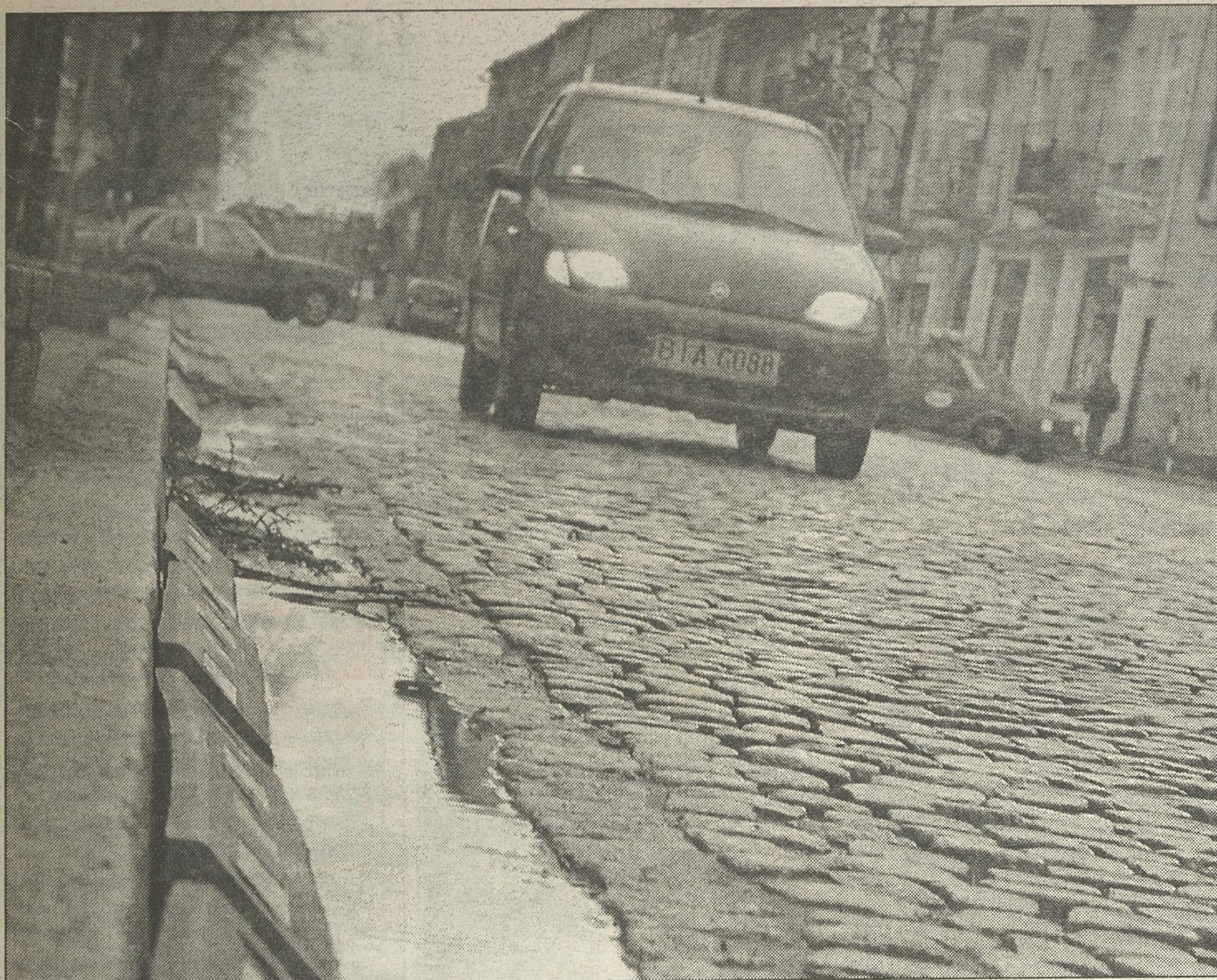
Progi zamontowano m.in. na ul. Lipowej
