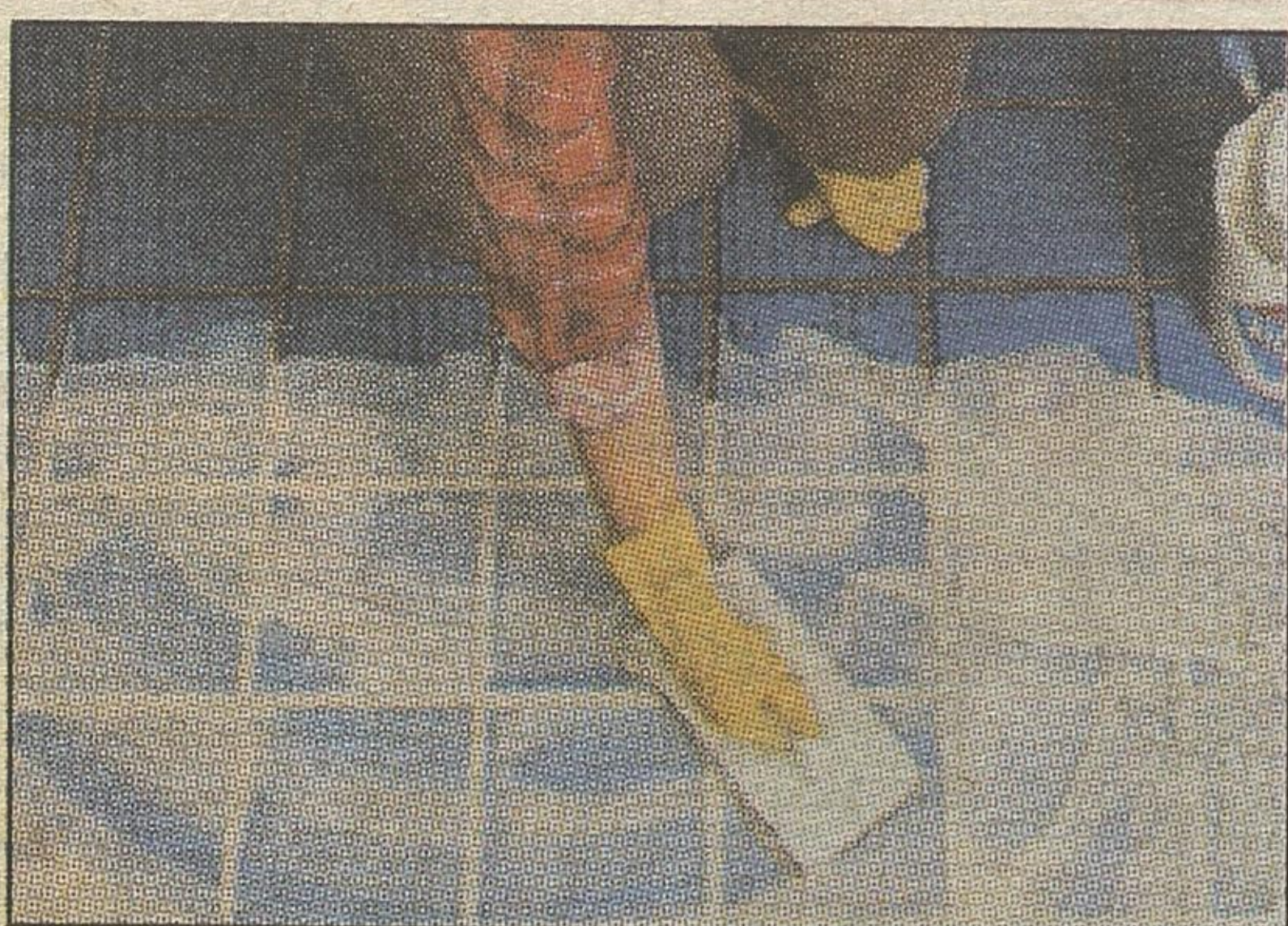
Fugę nakładamy, a nadmiar usuwamy gumową pędzelką
