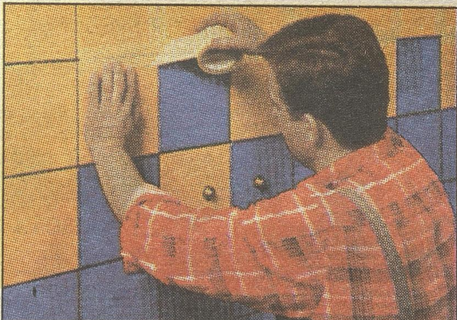
Miejsca łączenia kolorów trzeba zabezpieczyć taśmą
