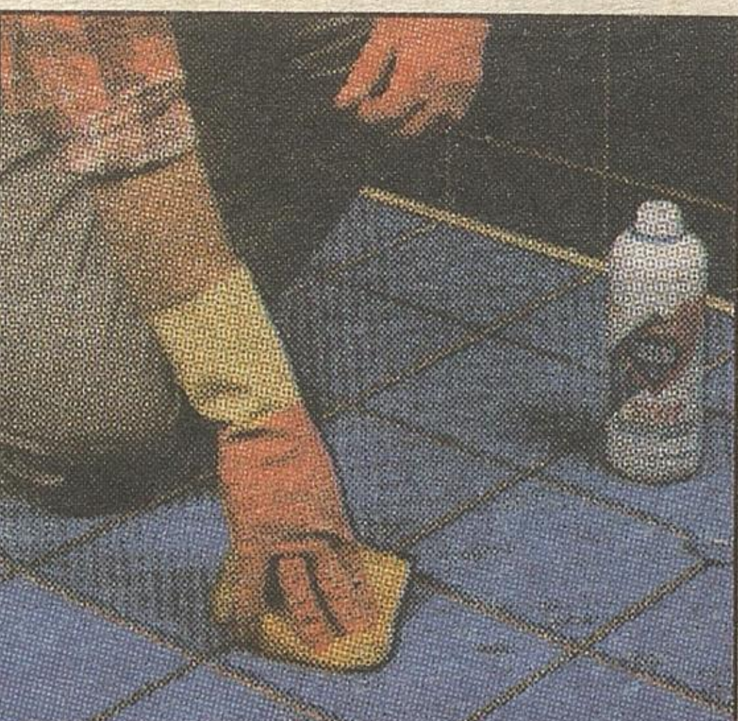
Przed fugowaniem posadzki trzeba usunąć resztki kleju
