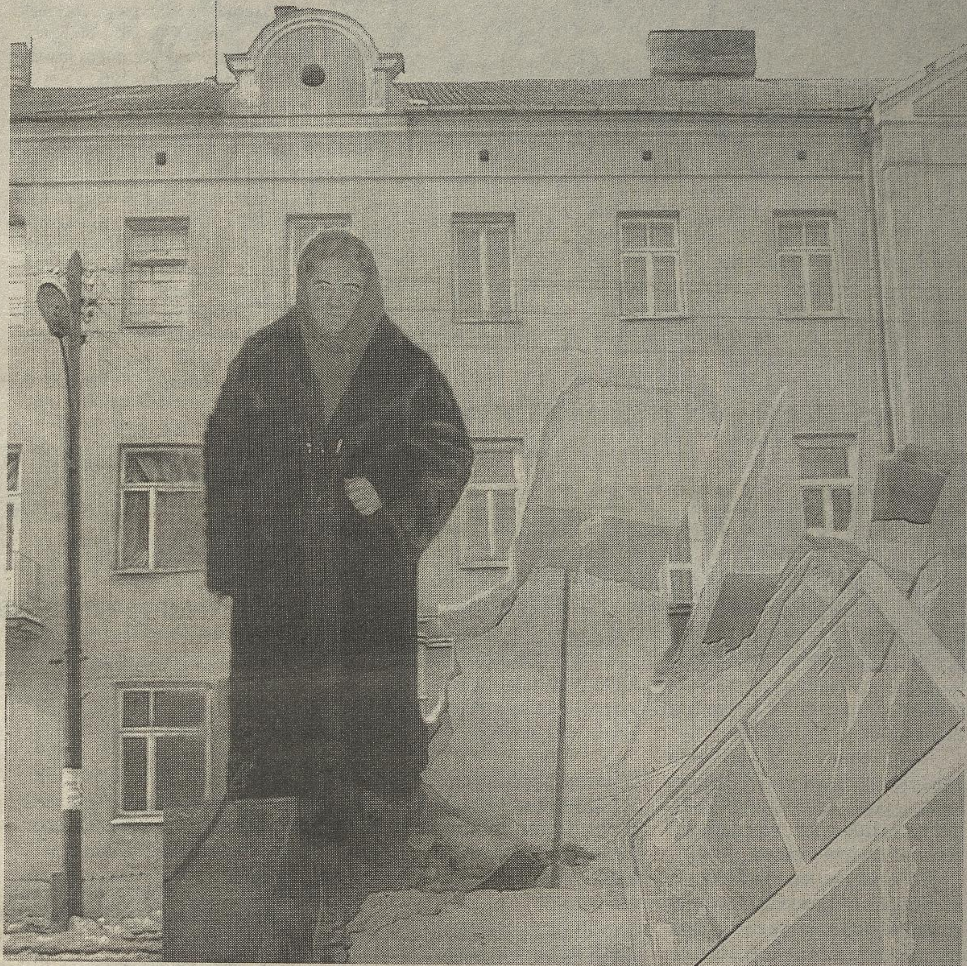
Kamienica przy ul. Bernatowicza nie ma szczęścia do lokatorów. W sąsiednim mieszkaniu na skutek eksplozji zniszczeniu uległy ścianki działowe
