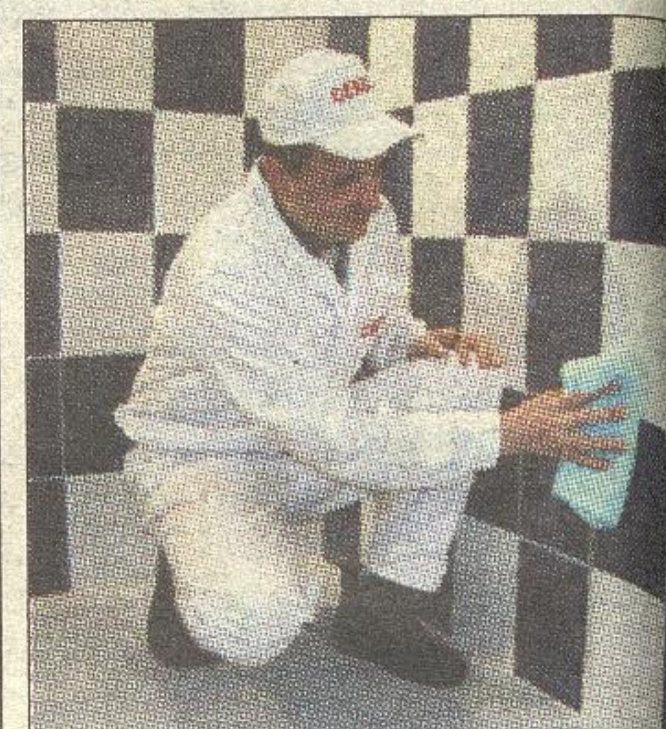
Przed ułożeniem nowych, trzeba dokładnie oczyścić stare płytki
