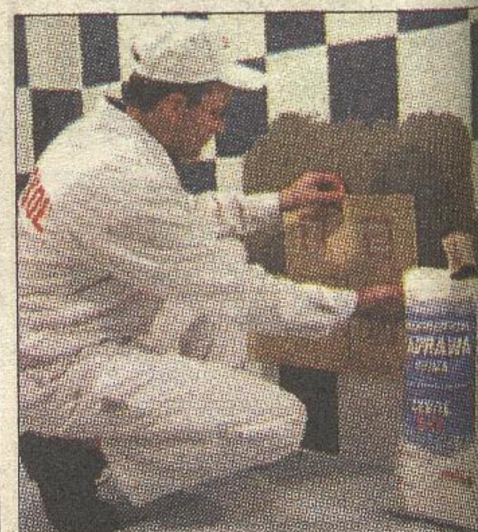
Płytki układamy na 3-4 mm kleju. 10 minut mamy na korektę
