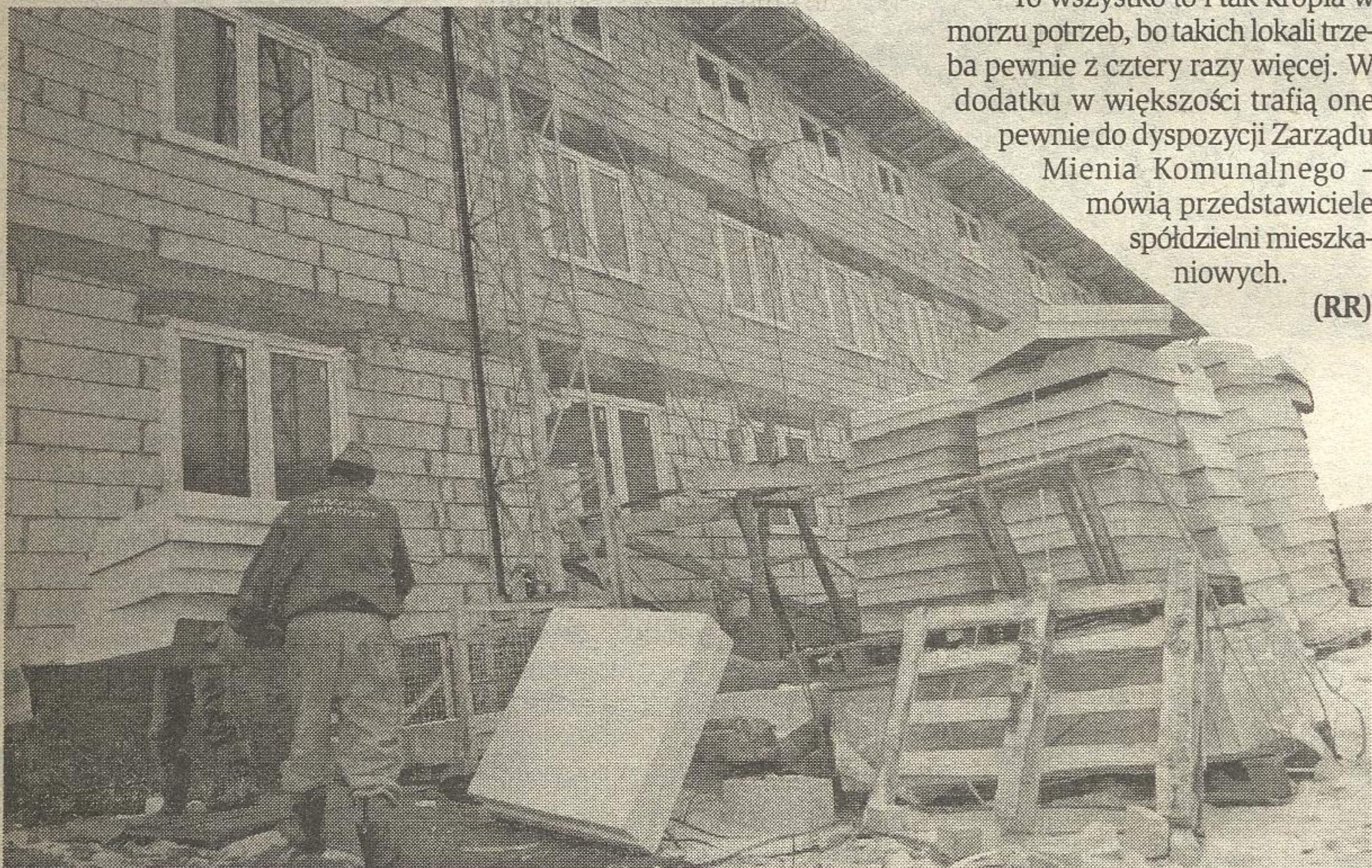
W tym roku przy ul. Dojnowskiej powstanie na razie 76 mieszkań
