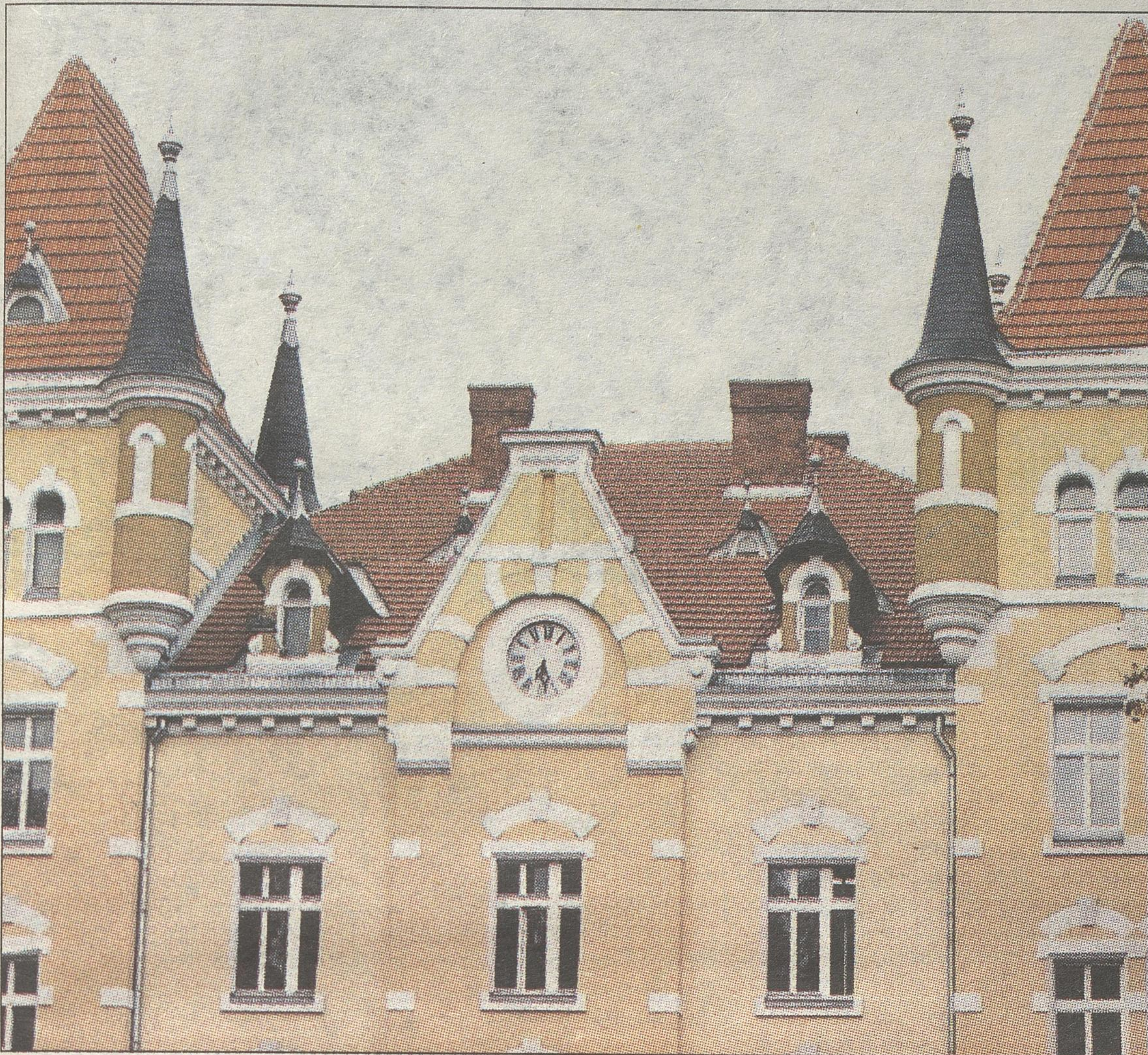
Płytki włókno-cementowe doskonale nadają się do renowacji dachów zabytkowych budynków. Zajmuje się tym m.in. białostocka firma Nexmar.
