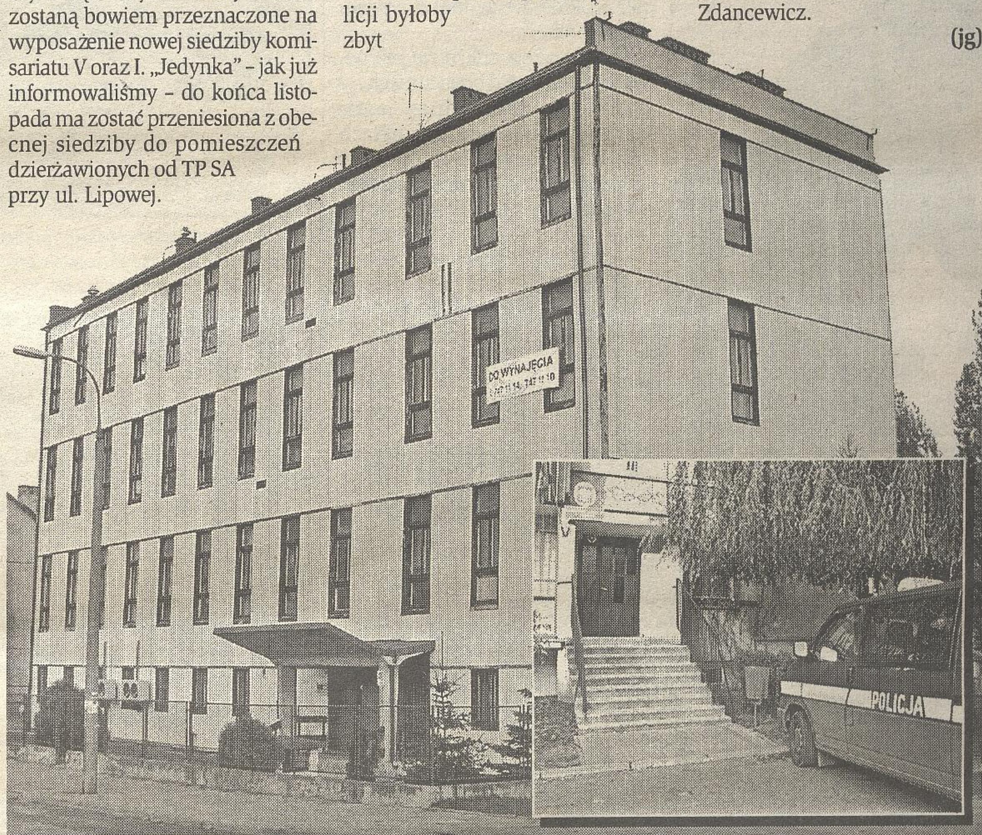
Policjanci z V komisariatu mają swoją siedzibę na parterze bloku mieszkalnego przy ul. Witosa. Po przeprowadzce do budynku telekomunikacji przy ul. Upalnej będzie im znacznie wygodniej.
