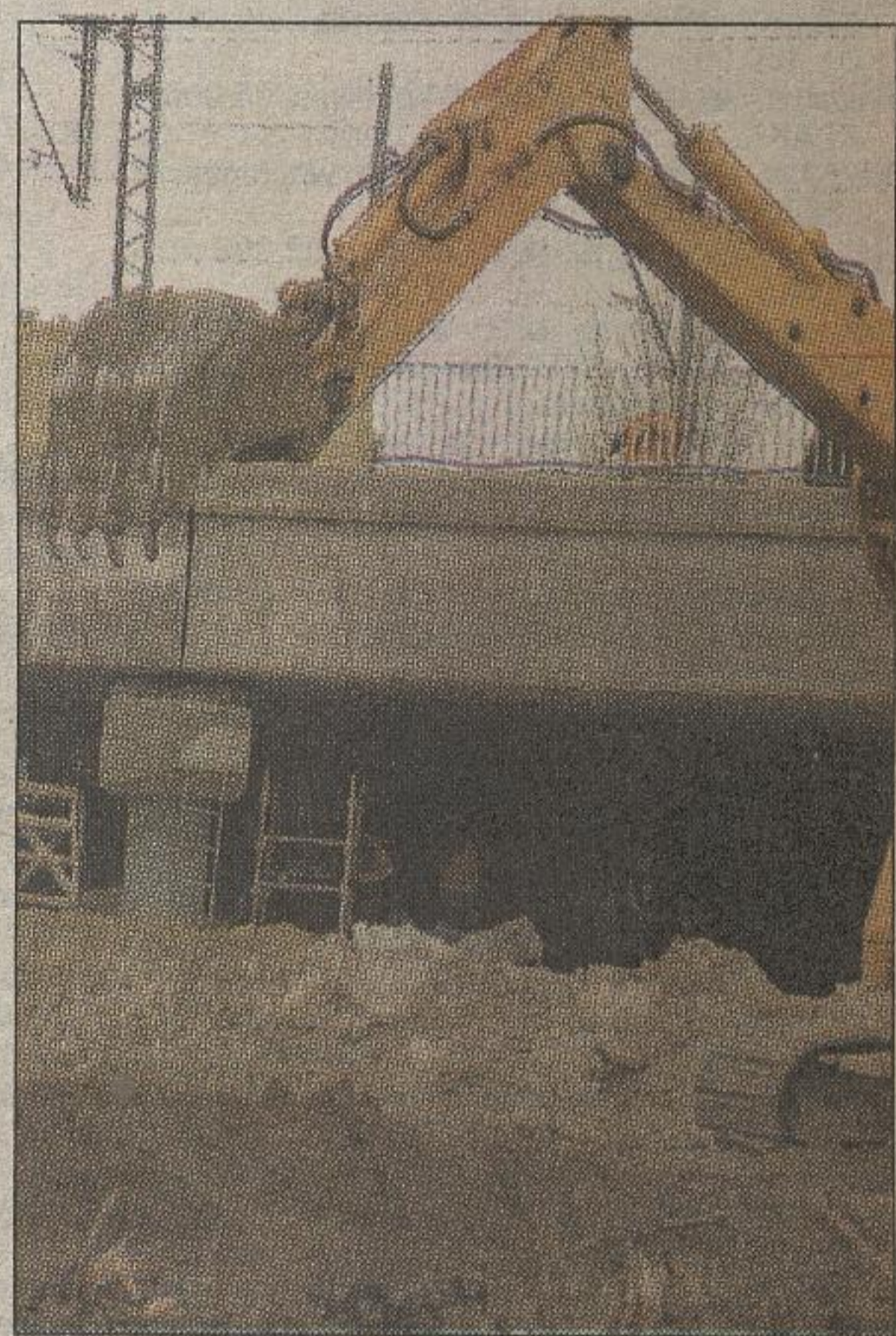
Obecnie trwa kończenie czwartego etapu budowy tunelu. Prace potwają do końca roku 2004, a od 2005 roku miasto będzie miało nowy łącznik obu swoich stron
