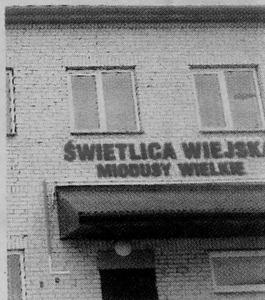
Świetlica w Miodusach Wielkich w środku już odnowiona
